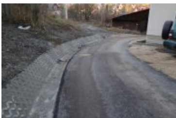
• 2023-12-28-Remont ulicy Wójtowiczowa
