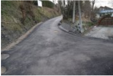
• 2023-12-28-Remont ulicy Wójtowiczowa
