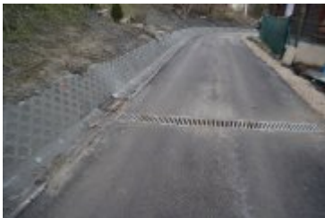
• 2023-12-28-Remont ulicy Wójtowiczowa
