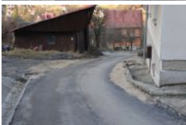
• 2023-12-28-Remont ulicy Wójtowiczowa
