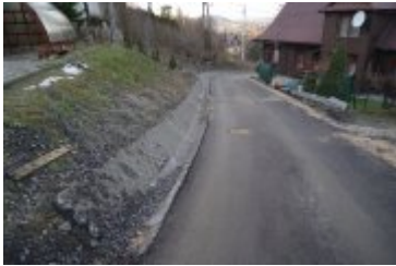
• 2023-12-28-Remont ulicy Wójtowiczowa
