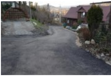
• 2023-12-28-Remont ulicy Wójtowiczowa
