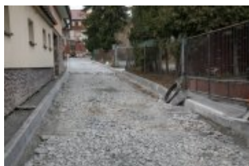
• 2021-11-08-Remont ulicy Zgody
