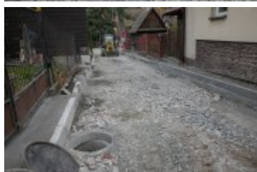
• 2021-11-08-Remont ulicy Zgody
