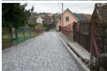
• 2021-11-08-Remont ulicy Zgody
