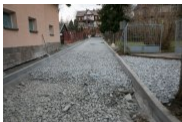
• 2021-11-08-Remont ulicy Zgody
