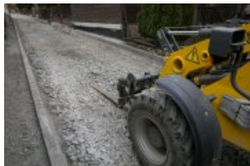
• 2021-11-08-Remont ulicy Zgody
