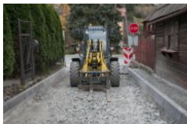
• 2021-11-08-Remont ulicy Zgody
