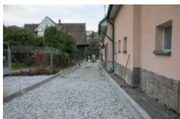
• 2021-11-08-Remont ulicy Zgody
