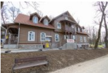
• 2024-03-29-Remont willi Anioł na finiszu
