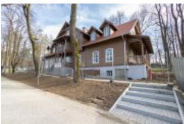
• 2024-03-29-Remont willi Anioł na finiszu
