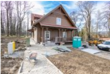
• 2024-03-29-Remont willi Anioł na finiszu
