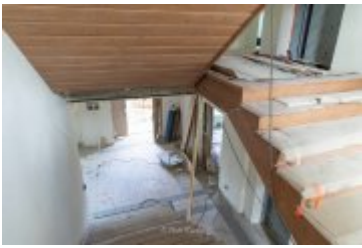
• 2024-03-29-Remont willi Anioł na finiszu
