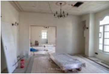
• 2024-03-29-Remont willi Anioł na finiszu
