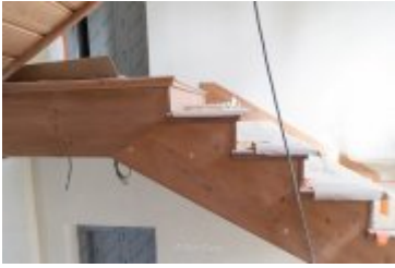
• 2024-03-29-Remont willi Anioł na finiszu
