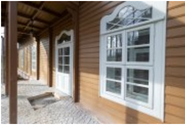
• 2024-03-29-Remont willi Anioł na finiszu
