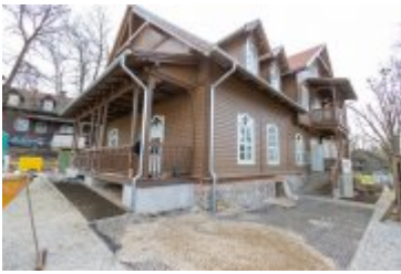
• 2024-03-29-Remont willi Anioł na finiszu
