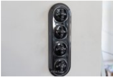
• 2024-03-29-Remont willi Anioł na finiszu
