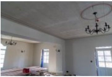
• 2024-03-29-Remont willi Anioł na finiszu
