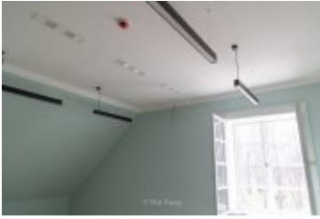
• 2024-03-29-Remont willi Anioł na finiszu
