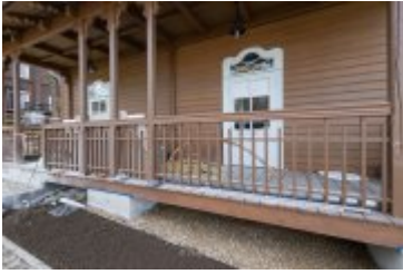
• 2024-03-29-Remont willi Anioł na finiszu
