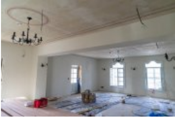
• 2024-03-29-Remont willi Anioł na finiszu
