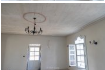
• 2024-03-29-Remont willi Anioł na finiszu
