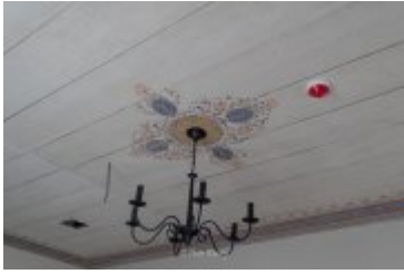
• 2024-03-29-Remont willi Anioł na finiszu
