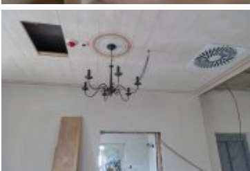
• 2024-03-29-Remont willi Anioł na finiszu
