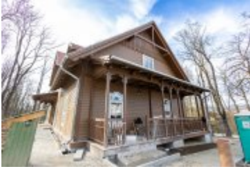
• 2024-03-29-Remont willi Anioł na finiszu
