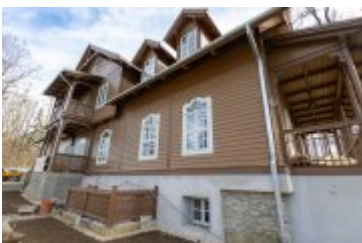
• 2024-03-29-Remont willi Anioł na finiszu
