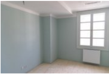
• 2024-03-29-Remont willi Anioł na finiszu
