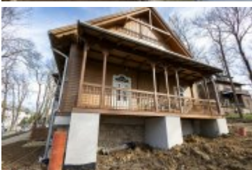
• 2024-03-29-Remont willi Anioł na finiszu
