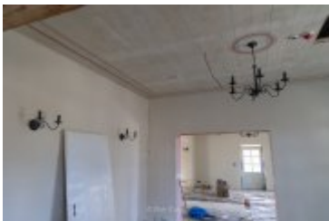
• 2024-03-29-Remont willi Anioł na finiszu
