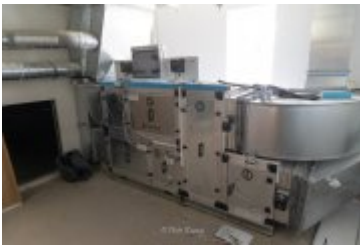
• 2024-03-29-Remont willi Anioł na finiszu
