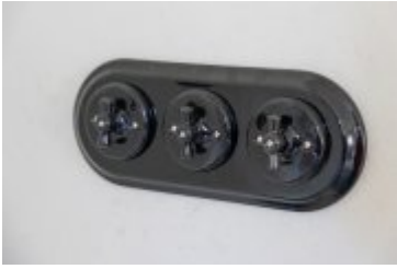
• 2024-03-29-Remont willi Anioł na finiszu
