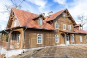
• 2024-03-29-Remont willi Anioł na finiszu
