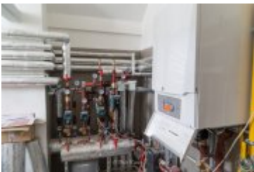
• 2024-03-29-Remont willi Anioł na finiszu
