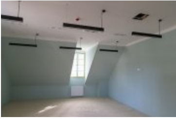
• 2024-03-29-Remont willi Anioł na finiszu
