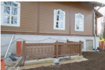
• 2024-03-29-Remont willi Anioł na finiszu
