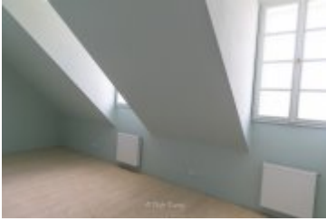
• 2024-03-29-Remont willi Anioł na finiszu
