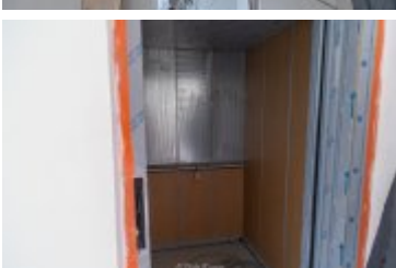
• 2024-03-29-Remont willi Anioł na finiszu
