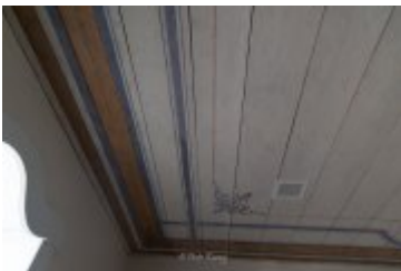
• 2024-03-29-Remont willi Anioł na finiszu
