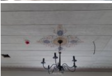
• 2024-03-29-Remont willi Anioł na finiszu
