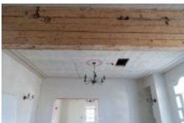
• 2024-03-29-Remont willi Anioł na finiszu
