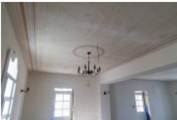
• 2024-03-29-Remont willi Anioł na finiszu
