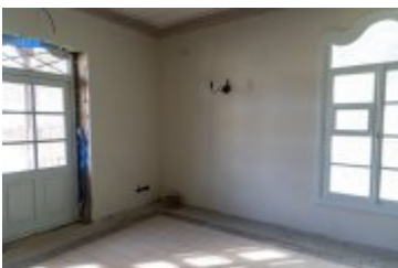
• 2024-03-29-Remont willi Anioł na finiszu
