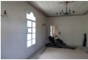
• 2024-03-29-Remont willi Anioł na finiszu
