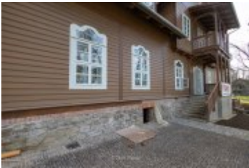
• 2024-03-29-Remont willi Anioł na finiszu
