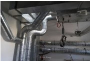
• 2024-03-29-Remont willi Anioł na finiszu
