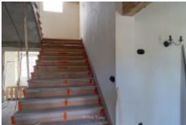
• 2024-03-29-Remont willi Anioł na finiszu
