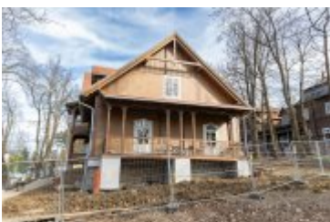
• 2024-03-29-Remont willi Anioł na finiszu
