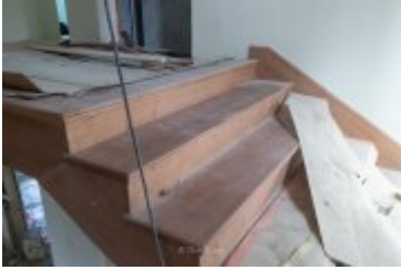
• 2024-03-29-Remont willi Anioł na finiszu
