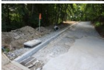
• 2022-06-17-Remont ulicy Brzozowej
