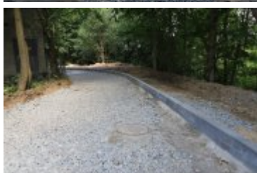
• 2022-06-17-Remont ulicy Brzozowej
