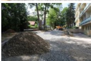
• 2022-06-17-Remont ulicy Brzozowej
