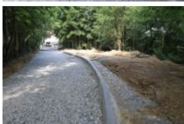
• 2022-06-17-Remont ulicy Brzozowej
