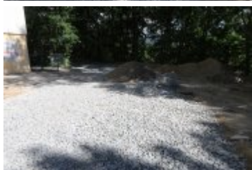
• 2022-06-17-Remont ulicy Brzozowej
