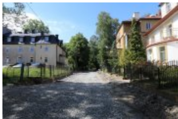
• 2022-06-17-Remont ulicy Brzozowej
