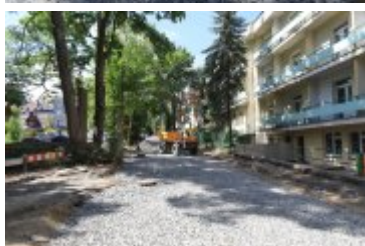
• 2022-06-17-Remont ulicy Brzozowej
