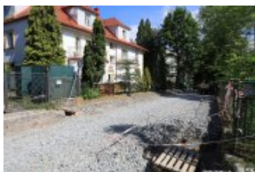
• 2022-06-17-Remont ulicy Brzozowej
