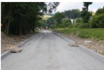
• 2023-06-29-Remont ulicy Poniatowskiego
