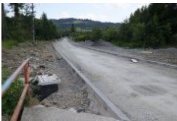
• 2023-06-29-Remont ulicy Poniatowskiego
