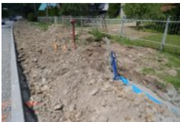
• 2023-06-29-Remont ulicy Poniatowskiego
