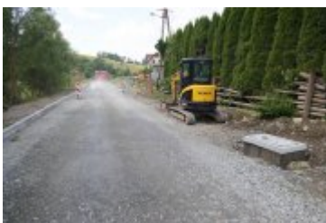
• 2023-06-29-Remont ulicy Poniatowskiego
