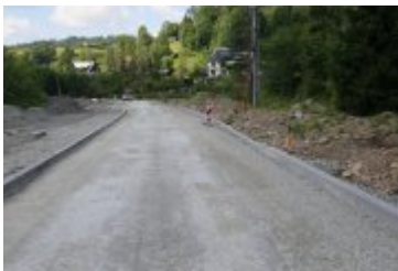
• 2023-06-29-Remont ulicy Poniatowskiego
