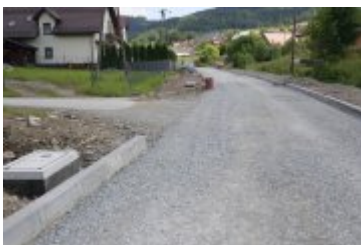
• 2023-06-29-Remont ulicy Poniatowskiego
