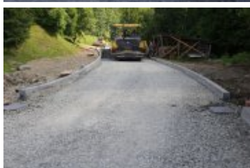
• 2023-06-29-Remont ulicy Poniatowskiego
