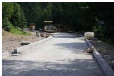
• 2023-06-29-Remont ulicy Poniatowskiego
