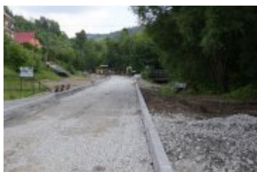
• 2023-06-29-Remont ulicy Poniatowskiego
