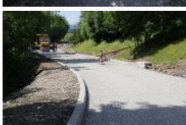
• 2023-06-29-Remont ulicy Poniatowskiego
