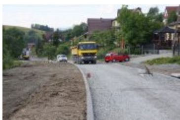
• 2023-06-29-Remont ulicy Poniatowskiego
