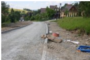
• 2023-06-29-Remont ulicy Poniatowskiego
