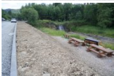
• 2023-06-29-Remont ulicy Poniatowskiego
