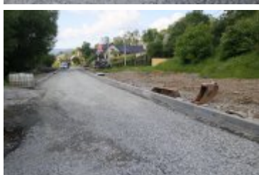
• 2023-06-29-Remont ulicy Poniatowskiego
