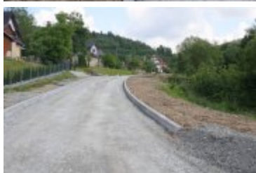
• 2023-06-29-Remont ulicy Poniatowskiego
