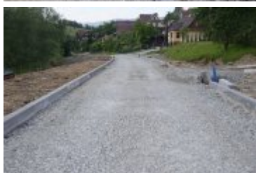
• 2023-06-29-Remont ulicy Poniatowskiego
