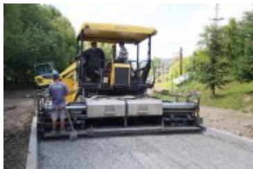
• 2023-06-29-Remont ulicy Poniatowskiego
