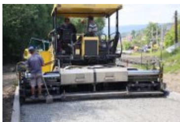
• 2023-06-29-Remont ulicy Poniatowskiego
