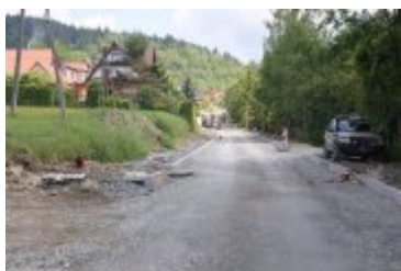
• 2023-06-29-Remont ulicy Poniatowskiego
