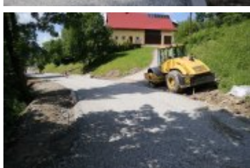
• 2023-06-29-Remont ulicy Poniatowskiego
