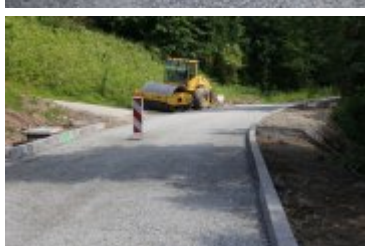
• 2023-06-29-Remont ulicy Poniatowskiego
