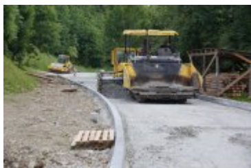
• 2023-06-29-Remont ulicy Poniatowskiego
