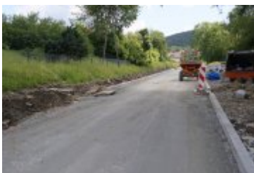
• 2023-06-29-Remont ulicy Poniatowskiego
