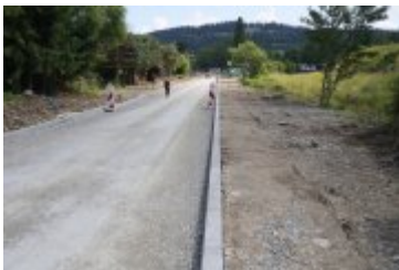
• 2023-06-29-Remont ulicy Poniatowskiego
