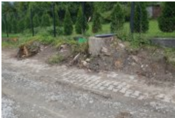
• 2023-08-10-Remont ulicy Bystrej
