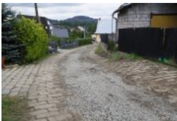
• 2023-08-10-Remont ulicy Bystrej
