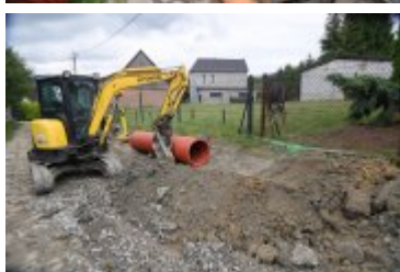
• 2023-08-10-Remont ulicy Bystrej
