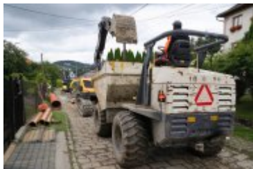
• 2023-08-10-Remont ulicy Bystrej
