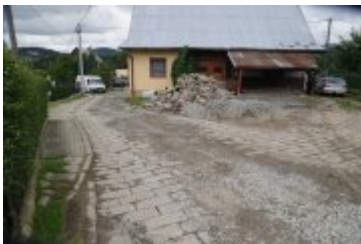
• 2023-08-10-Remont ulicy Bystrej
