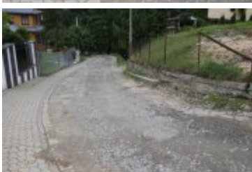
• 2023-08-10-Remont ulicy Bystrej
