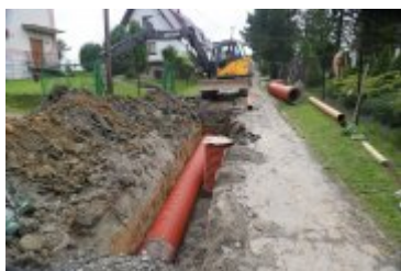
• 2023-08-10-Remont ulicy Bystrej
