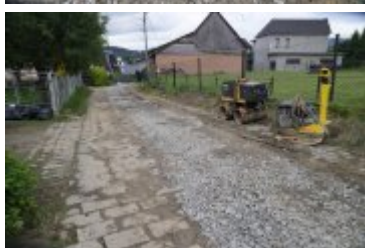
• 2023-08-10-Remont ulicy Bystrej
