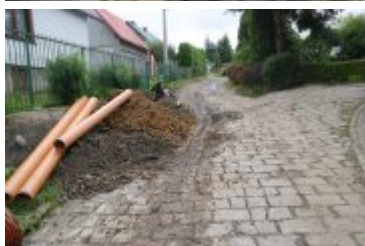
• 2023-08-10-Remont ulicy Bystrej
