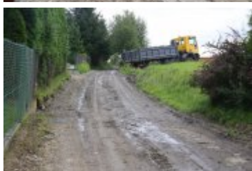
• 2023-08-10-Remont ulicy Bystrej
