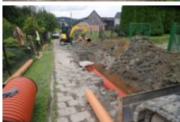
• 2023-08-10-Remont ulicy Bystrej
