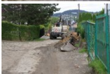
• 2023-08-10-Remont ulicy Bystrej
