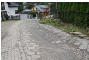
• 2023-08-10-Remont ulicy Bystrej
