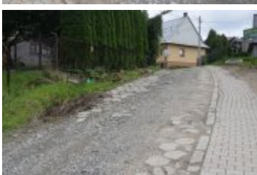
• 2023-08-10-Remont ulicy Bystrej
