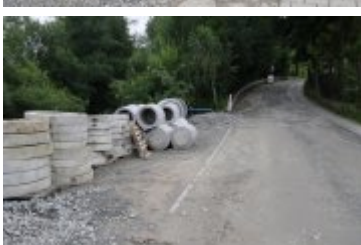
• 2023-08-10-Remont ulicy Bystrej
