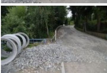
• 2023-08-10-Remont ulicy Bystrej
