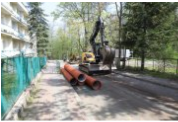
• 2022-05-11-Remont ulicy Brzozowej
