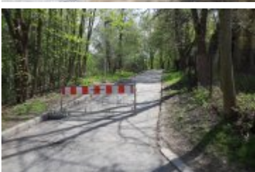
• 2022-05-11-Remont ulicy Brzozowej
