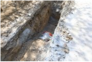
• 2022-05-11-Remont ulicy Brzozowej
