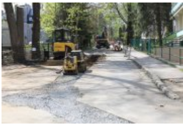
• 2022-05-11-Remont ulicy Brzozowej
