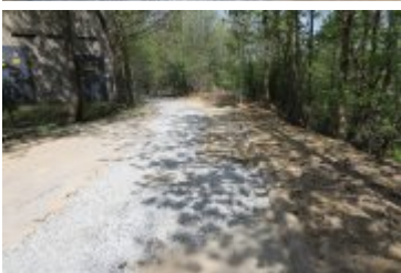
• 2022-05-11-Remont ulicy Brzozowej
