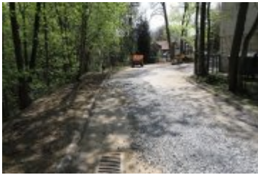
• 2022-05-11-Remont ulicy Brzozowej
