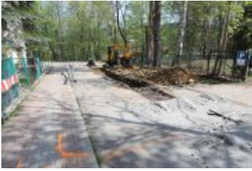
• 2022-05-11-Remont ulicy Brzozowej
