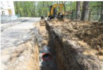
• 2022-05-11-Remont ulicy Brzozowej
