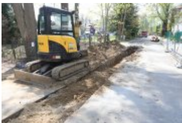
• 2022-05-11-Remont ulicy Brzozowej
