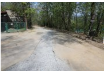
• 2022-05-11-Remont ulicy Brzozowej
