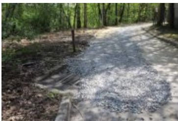
• 2022-05-11-Remont ulicy Brzozowej
