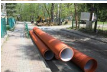
• 2022-05-11-Remont ulicy Brzozowej
