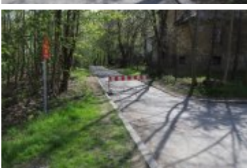
• 2022-05-11-Remont ulicy Brzozowej
