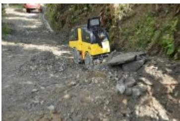
• 2023-09-04-Przebudowa ulicy Gorczańskiej
