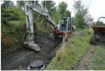
• 2023-09-04-Przebudowa ulicy Gorczańskiej
