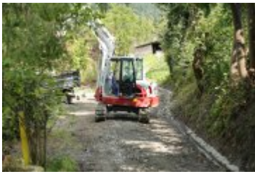
• 2023-09-04-Przebudowa ulicy Gorczańskiej
