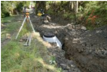
• 2023-09-04-Przebudowa ulicy Gorczańskiej
