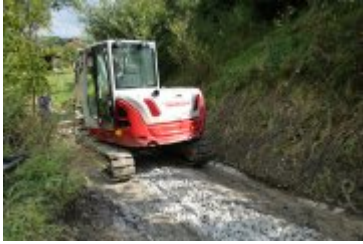
• 2023-09-04-Przebudowa ulicy Gorczańskiej
