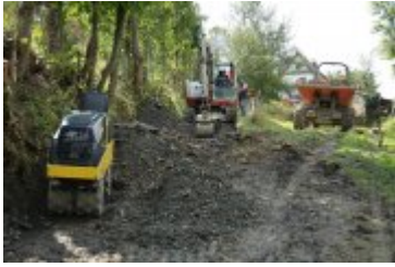
• 2023-09-04-Przebudowa ulicy Gorczańskiej
