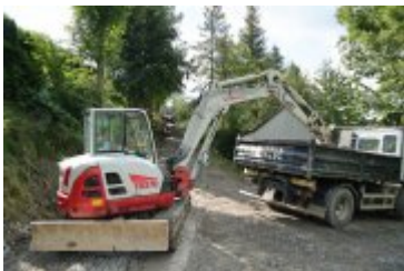
• 2023-09-04-Przebudowa ulicy Gorczańskiej
