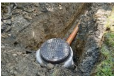
• 2023-09-04-Przebudowa ulicy Gorczańskiej
