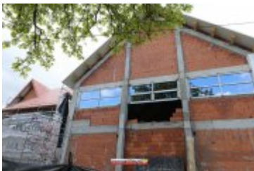
2017-05-09-Budowa sali gimnastycznej w Ponicach
