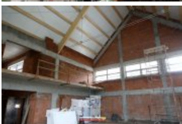
• 2017-05-09-Budowa sali gimnastycznej w Ponicach
