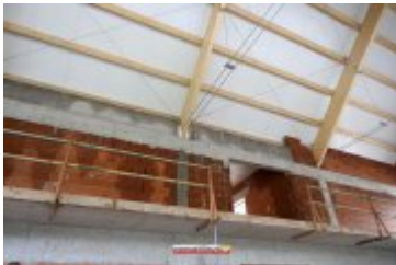
2017-05-09-Budowa sali gimnastycznej w Ponicach
