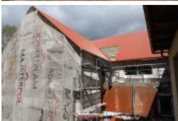
• 2017-05-09-Budowa sali gimnastycznej w Ponicach
