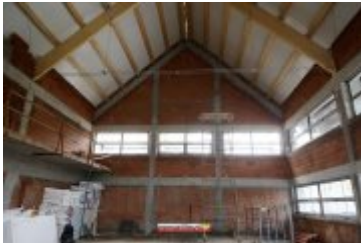
2017-05-09-Budowa sali gimnastycznej w Ponicach
