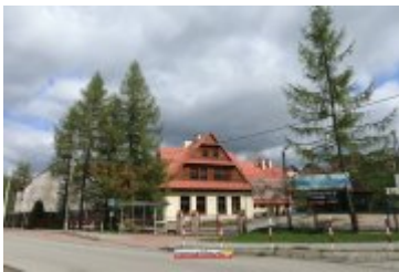
• 2017-05-09-Budowa sali gimnastycznej w Ponicach
