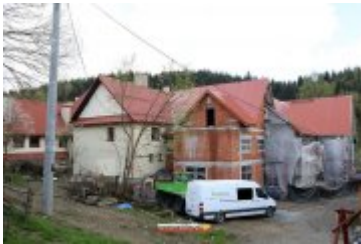
2017-05-09-Budowa sali gimnastycznej w Ponicach
