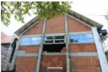
2017-05-09-Budowa sali gimnastycznej w Ponicach
