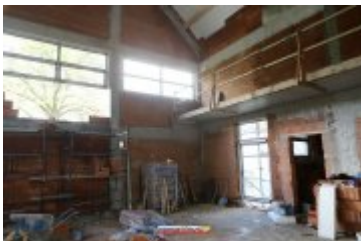
2017-05-09-Budowa sali gimnastycznej w Ponicach
