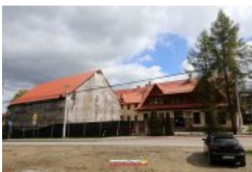
• 2017-05-09-Budowa sali gimnastycznej w Ponicach
