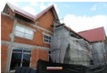
2017-05-09-Budowa sali gimnastycznej w Ponicach
