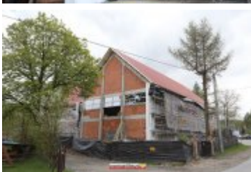
• 2017-05-09-Budowa sali gimnastycznej w Ponicach
