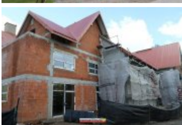
• 2017-05-09-Budowa sali gimnastycznej w Ponicach
