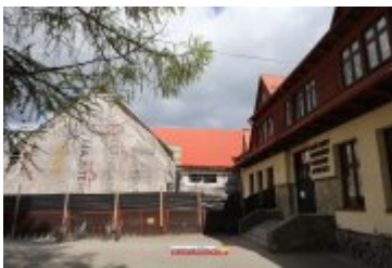
• 2017-05-09-Budowa sali gimnastycznej w Ponicach
