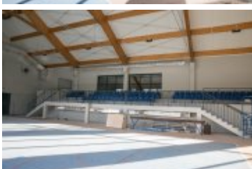
• 2021-11-25-Budowa sali gimnastycznej w Chabówce
