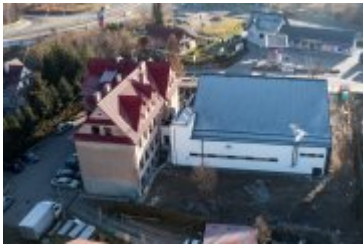
• 2021-11-25-Budowa sali gimnastycznej w Chabówce
