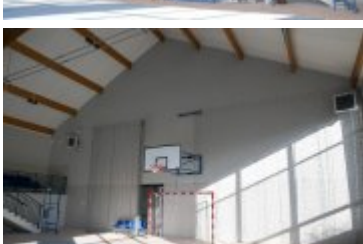
• 2021-11-25-Budowa sali gimnastycznej w Chabówce
