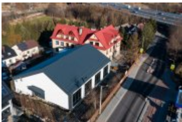
• 2021-11-25-Budowa sali gimnastycznej w Chabówce
