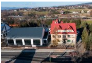
• 2021-11-25-Budowa sali gimnastycznej w Chabówce
