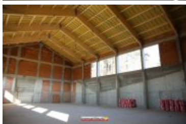
• 2017-11-17-Budowa sali gimnastycznej przy II LO
