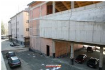
• 2017-11-17-Budowa sali gimnastycznej przy II LO
