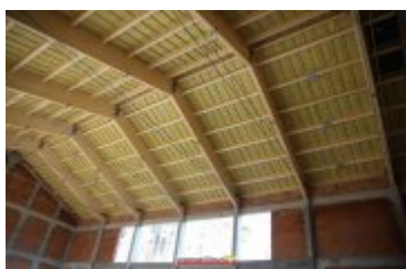
• 2017-11-17-Budowa sali gimnastycznej przy II LO
