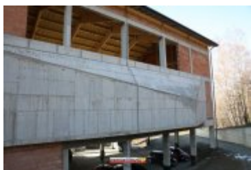
• 2017-11-17-Budowa sali gimnastycznej przy II LO
