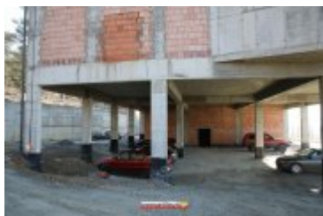
• 2017-11-17-Budowa sali gimnastycznej przy II LO
