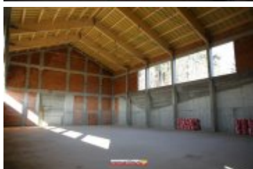
• 2017-11-17-Budowa sali gimnastycznej przy II LO
