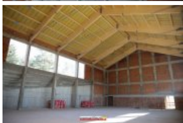
• 2017-11-17-Budowa sali gimnastycznej przy II LO
