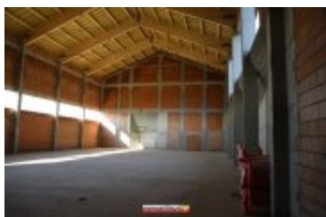
• 2017-11-17-Budowa sali gimnastycznej przy II LO
