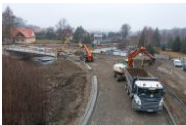
• 2022-03-31-Budowa mostu nad Poniczanką na finiszu
