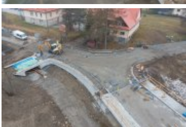
• 2022-03-31-Budowa mostu nad Poniczanką na finiszu
