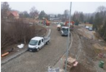
• 2022-03-31-Budowa mostu nad Poniczanką na finiszu
