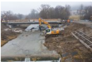
• 2022-03-31-Budowa mostu nad Poniczanką na finiszu
