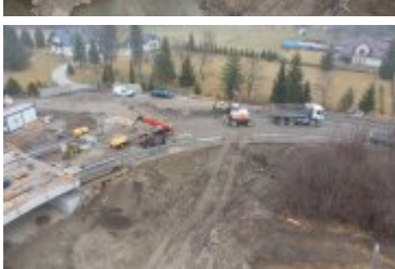
• 2022-03-31-Budowa mostu nad Poniczanką na finiszu
