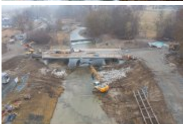
• 2022-03-31-Budowa mostu nad Poniczanką na finiszu
