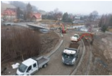
• 2022-03-31-Budowa mostu nad Poniczanką na finiszu
