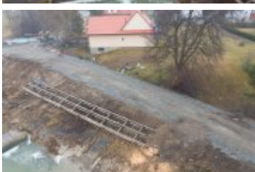
• 2022-03-31-Budowa mostu nad Poniczanką na finiszu
