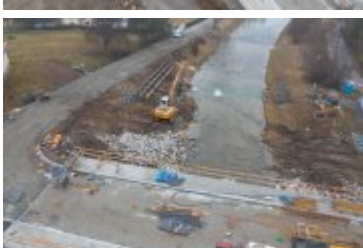
• 2022-03-31-Budowa mostu nad Poniczanką na finiszu
