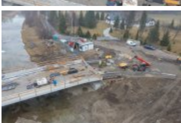
• 2022-03-31-Budowa mostu nad Poniczanką na finiszu
