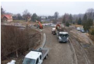
• 2022-03-31-Budowa mostu nad Poniczanką na finiszu
