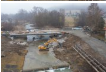
• 2022-03-31-Budowa mostu nad Poniczanką na finiszu
