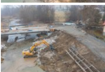
• 2022-03-31-Budowa mostu nad Poniczanką na finiszu
