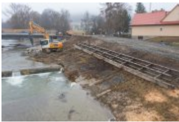
• 2022-03-31-Budowa mostu nad Poniczanką na finiszu
