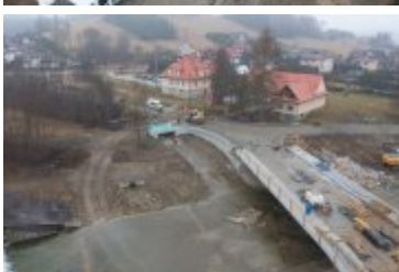
• 2022-03-31-Budowa mostu nad Poniczanką na finiszu
