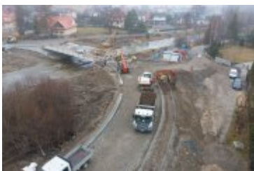
• 2022-03-31-Budowa mostu nad Poniczanką na finiszu
