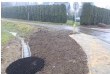
• 2020-12-23-Remont drogi na osiedlu Traczykówka
