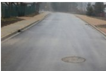
• 2020-12-23-Remont drogi na osiedlu Traczykówka
