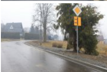
• 2020-12-23-Remont drogi na osiedlu Traczykówka
