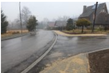
• 2020-12-23-Remont drogi na osiedlu Traczykówka
