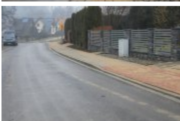
• 2020-12-23-Remont drogi na osiedlu Traczykówka
