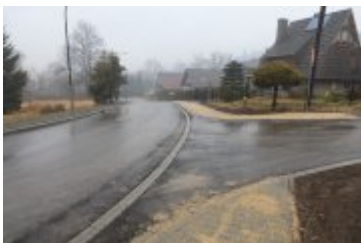
• 2020-12-23-Remont drogi na osiedlu Traczykówka
