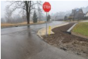
• 2020-12-23-Remont drogi na osiedlu Traczykówka
