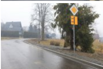
• 2020-12-23-Remont drogi na osiedlu Traczykówka
