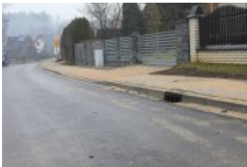
• 2020-12-23-Remont drogi na osiedlu Traczykówka
