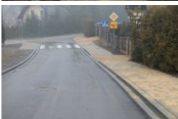
• 2020-12-23-Remont drogi na osiedlu Traczykówka
