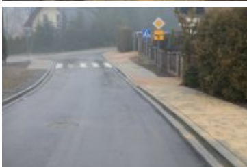
• 2020-12-23-Remont drogi na osiedlu Traczykówka
