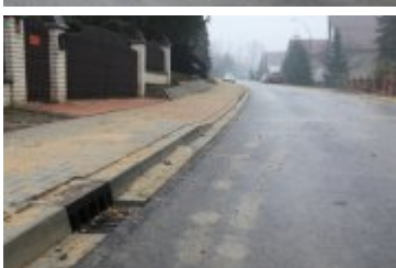
• 2020-12-23-Remont drogi na osiedlu Traczykówka
