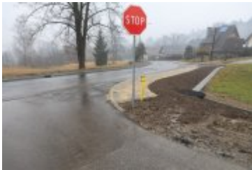
• 2020-12-23-Remont drogi na osiedlu Traczykówka
