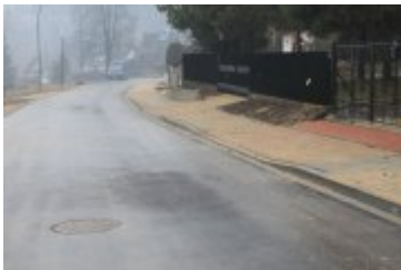
• 2020-12-23-Remont drogi na osiedlu Traczykówka
