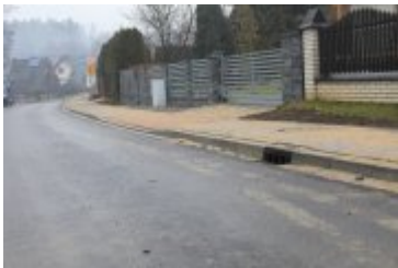
• 2020-12-23-Remont drogi na osiedlu Traczykówka
