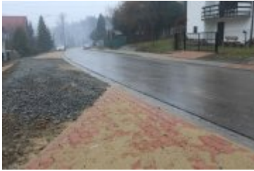
• 2020-12-23-Remont drogi na osiedlu Traczykówka
