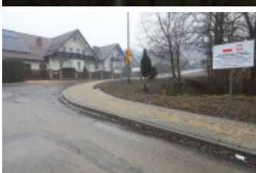
• 2020-12-23-Remont drogi na osiedlu Traczykówka
