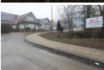
• 2020-12-23-Remont drogi na osiedlu Traczykówka
