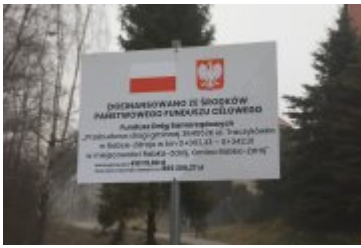
• 2020-12-23-Remont drogi na osiedlu Traczykówka
