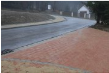
• 2020-12-23-Remont drogi na osiedlu Traczykówka
