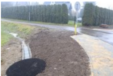
• 2020-12-23-Remont drogi na osiedlu Traczykówka
