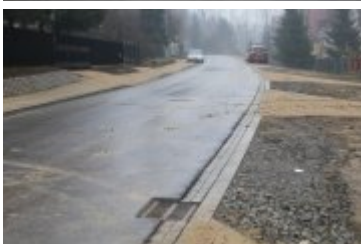
• 2020-12-23-Remont drogi na osiedlu Traczykówka
