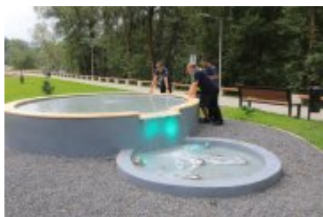
• 2019-09-02-Odbiory techniczne bulwarów nad Poniczanką
