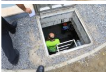
• 2019-09-02-Odbiory techniczne bulwarów nad Poniczanką
