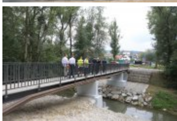
• 2019-09-02-Odbiory techniczne bulwarów nad Poniczanką
