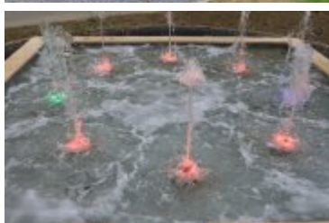
• 2019-09-02-Odbiory techniczne bulwarów nad Poniczanką
