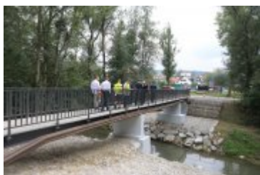
• 2019-09-02-Odbiory techniczne bulwarów nad Poniczanką
