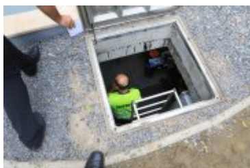
• 2019-09-02-Odbiory techniczne bulwarów nad Poniczanką
