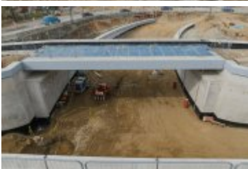
• 2025-03-12- Przebudowa ul. Zakopiańskiej
