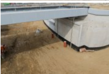
• 2025-03-12- Przebudowa ul. Zakopiańskiej
