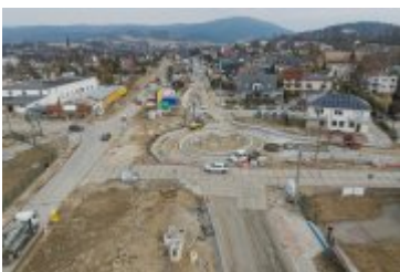
• 2025-03-12- Przebudowa ul. Zakopiańskiej
