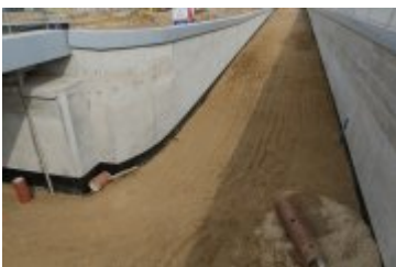
• 2025-03-12- Przebudowa ul. Zakopiańskiej
