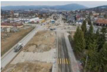
• 2025-03-12- Przebudowa ul. Zakopiańskiej
