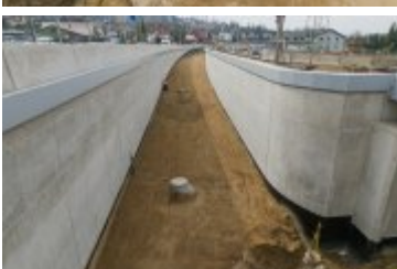
• 2025-03-12- Przebudowa ul. Zakopiańskiej
