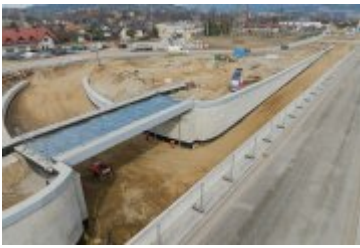
• 2025-03-12- Przebudowa ul. Zakopiańskiej
