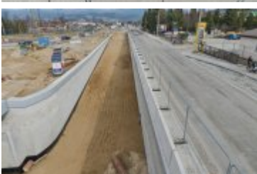
• 2025-03-12- Przebudowa ul. Zakopiańskiej
