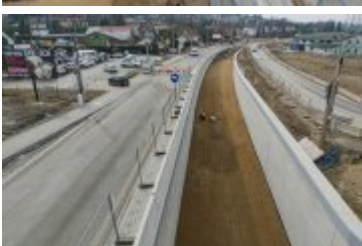
• 2025-03-12- Przebudowa ul. Zakopiańskiej
