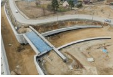
• 2025-03-12- Przebudowa ul. Zakopiańskiej
