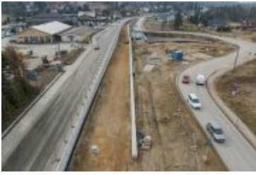
• 2025-03-12- Przebudowa ul. Zakopiańskiej
