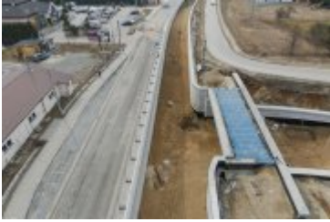
• 2025-03-12- Przebudowa ul. Zakopiańskiej
