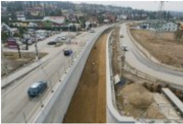
• 2025-03-12- Przebudowa ul. Zakopiańskiej
