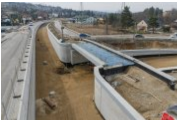
• 2025-03-12- Przebudowa ul. Zakopiańskiej
