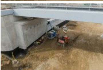
• 2025-03-12- Przebudowa ul. Zakopiańskiej
