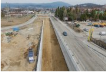
• 2025-03-12- Przebudowa ul. Zakopiańskiej
