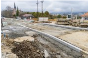
• 2025-03-27- Ulica Orkana wkrótce przejezdna
