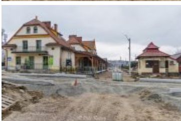
• 2025-03-27- Ulica Orkana wkrótce przejezdna
