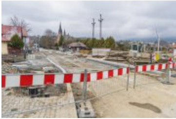
• 2025-03-27- Ulica Orkana wkrótce przejezdna
