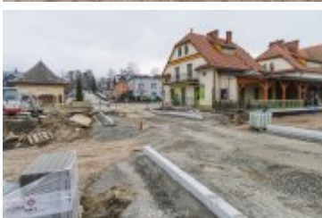
• 2025-03-27- Ulica Orkana wkrótce przejezdna
