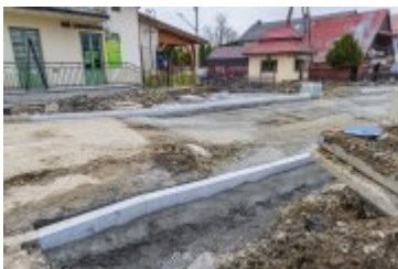
• 2025-03-27- Ulica Orkana wkrótce przejezdna
