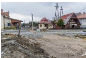
• 2025-03-27- Ulica Orkana wkrótce przejezdna
