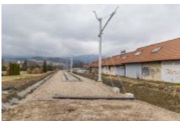
• 2025-03-27- Ulica Orkana wkrótce przejezdna
