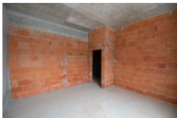
• 2019-01-23-Budowa nowej siedziby Teatru Rabcio
