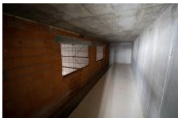
• 2019-01-23-Budowa nowej siedziby Teatru Rabcio
