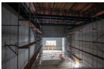
• 2019-01-23-Budowa nowej siedziby Teatru Rabcio
