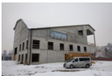
• 2019-01-23-Budowa nowej siedziby Teatru Rabcio
