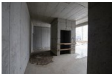
• 2019-01-23-Budowa nowej siedziby Teatru Rabcio
