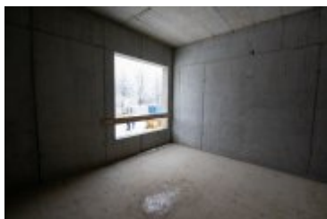
• 2019-01-23-Budowa nowej siedziby Teatru Rabcio
