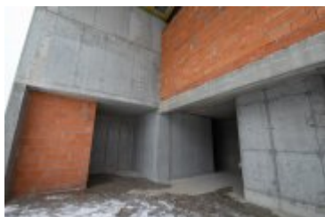
• 2019-01-23-Budowa nowej siedziby Teatru Rabcio
