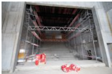
• 2019-01-23-Budowa nowej siedziby Teatru Rabcio
