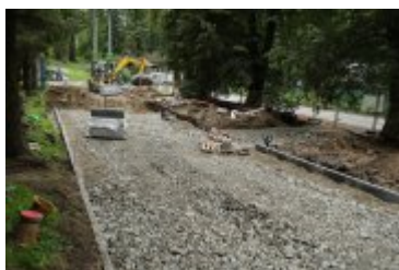
• 2023-08-29-Remont rabczańskiego deptaka
