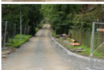
• 2023-08-29-Remont rabczańskiego deptaka
