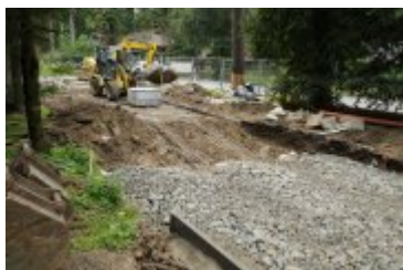
• 2023-08-29-Remont rabczańskiego deptaka
