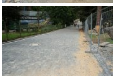
• 2023-08-29-Remont rabczańskiego deptaka
