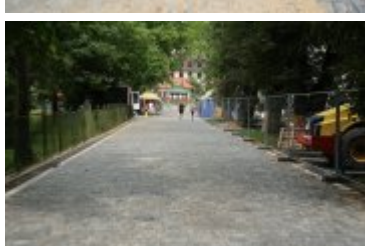
• 2023-08-29-Remont rabczańskiego deptaka
