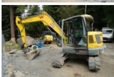
• 2023-08-29-Remont rabczańskiego deptaka
