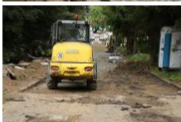
• 2023-08-29-Remont rabczańskiego deptaka
