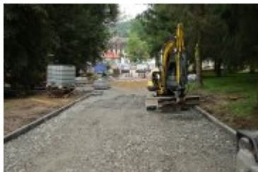
• 2023-08-29-Remont rabczańskiego deptaka
