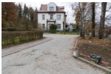
• 2023-11-16-Zakończenie remontu na os. Chopina
