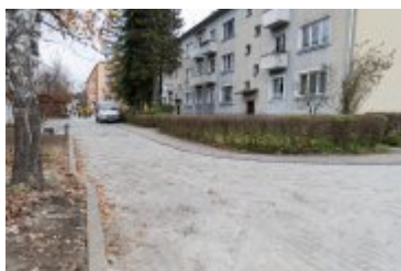
• 2023-11-16-Zakończenie remontu na os. Chopina
