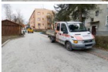
• 2023-11-16-Zakończenie remontu na os. Chopina
