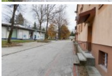
• 2023-11-16-Zakończenie remontu na os. Chopina
