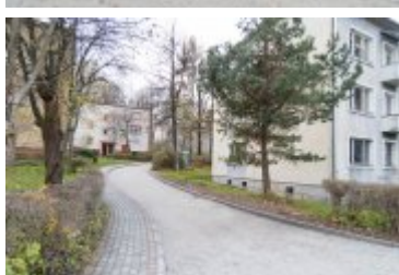
• 2023-11-16-Zakończenie remontu na os. Chopina
