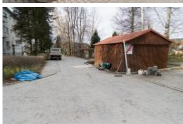
• 2023-11-16-Zakończenie remontu na os. Chopina
