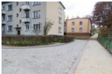
• 2023-11-16-Zakończenie remontu na os. Chopina
