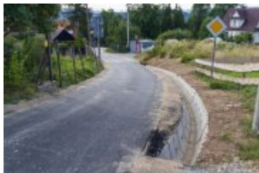
• 2025-08-20- Remont górnego odcinka ul. Gorczańskiej
