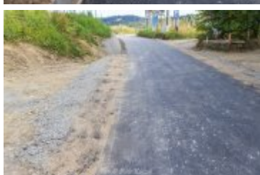
• 2025-08-20- Remont górnego odcinka ul. Gorczańskiej
