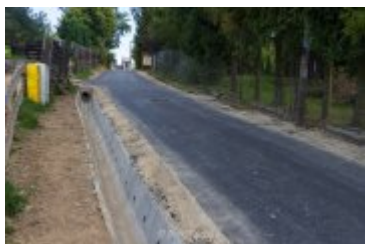
• 2025-08-20- Remont górnego odcinka ul. Gorczańskiej
