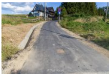
• 2025-08-20- Remont górnego odcinka ul. Gorczańskiej
