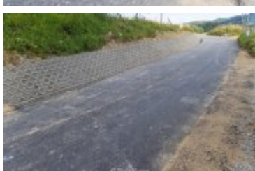
• 2025-08-20- Remont górnego odcinka ul. Gorczańskiej
