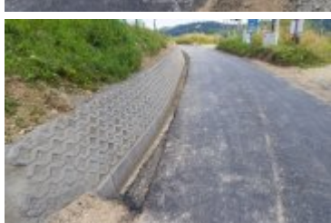
• 2025-08-20- Remont górnego odcinka ul. Gorczańskiej
