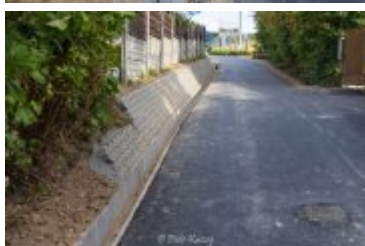
• 2025-08-20- Remont górnego odcinka ul. Gorczańskiej
