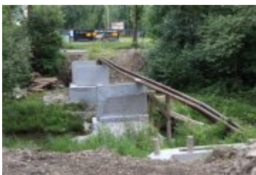
• 2019-06-24-Postępy prac na budowie bulwarów nad Poniczanką
