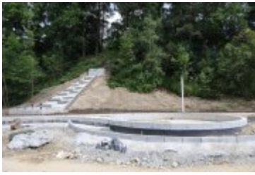
• 2019-06-24-Postępy prac na budowie bulwarów nad Poniczanką
