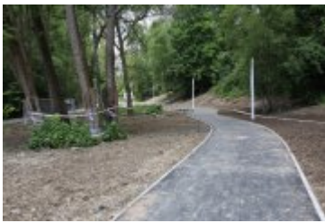
• 2019-06-24-Postępy prac na budowie bulwarów nad Poniczanką
