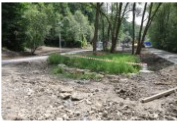
• 2019-06-24-Postępy prac na budowie bulwarów nad Poniczanką
