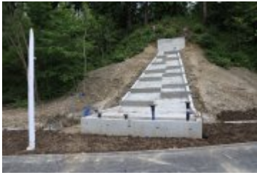
• 2019-06-24-Postępy prac na budowie bulwarów nad Poniczanką
