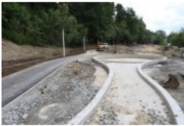
• 2019-06-24-Postępy prac na budowie bulwarów nad Poniczanką
