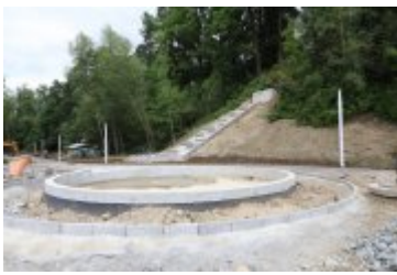
• 2019-06-24-Postępy prac na budowie bulwarów nad Poniczanką
