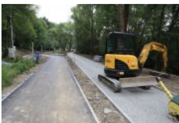
• 2019-06-24-Postępy prac na budowie bulwarów nad Poniczanką
