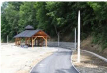
• 2019-06-24-Postępy prac na budowie bulwarów nad Poniczanką
