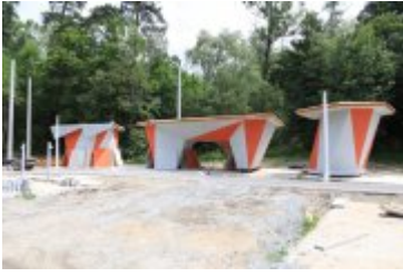
• 2019-06-24-Postępy prac na budowie bulwarów nad Poniczanką
