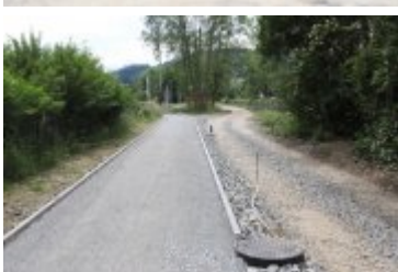
• 2019-06-24-Postępy prac na budowie bulwarów nad Poniczanką
