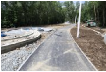
• 2019-06-24-Postępy prac na budowie bulwarów nad Poniczanką
