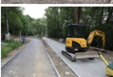
• 2019-06-24-Postępy prac na budowie bulwarów nad Poniczanką
