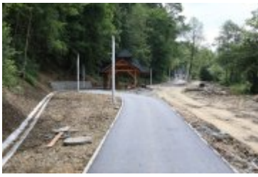
• 2019-06-24-Postępy prac na budowie bulwarów nad Poniczanką
