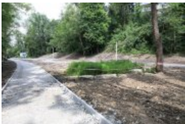
• 2019-06-24-Postępy prac na budowie bulwarów nad Poniczanką
