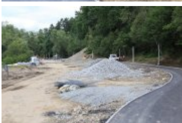
• 2019-06-24-Postępy prac na budowie bulwarów nad Poniczanką
