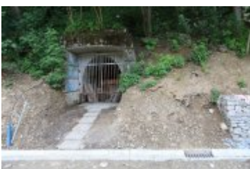
• 2019-06-24-Postępy prac na budowie bulwarów nad Poniczanką
