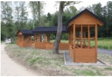
• 2019-06-24-Postępy prac na budowie bulwarów nad Poniczanką
