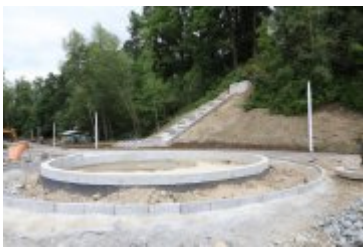
• 2019-06-24-Postępy prac na budowie bulwarów nad Poniczanką
