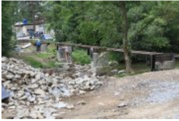
• 2019-06-24-Postępy prac na budowie bulwarów nad Poniczanką
