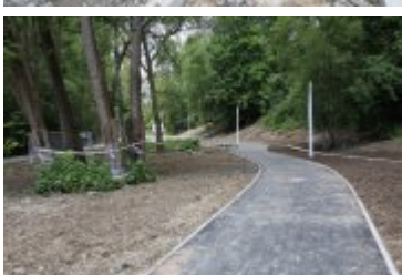
• 2019-06-24-Postępy prac na budowie bulwarów nad Poniczanką
