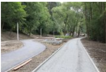
• 2019-06-24-Postępy prac na budowie bulwarów nad Poniczanką
