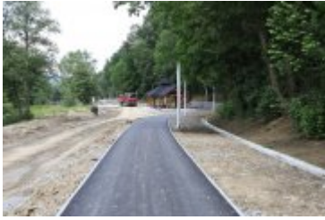
• 2019-06-24-Postępy prac na budowie bulwarów nad Poniczanką
