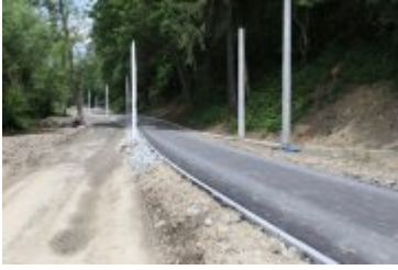
• 2019-06-24-Postępy prac na budowie bulwarów nad Poniczanką
