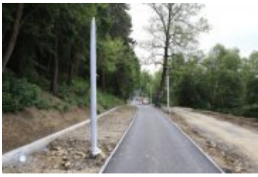
• 2019-06-24-Postępy prac na budowie bulwarów nad Poniczanką
