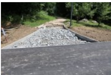
• 2019-06-24-Postępy prac na budowie bulwarów nad Poniczanką
