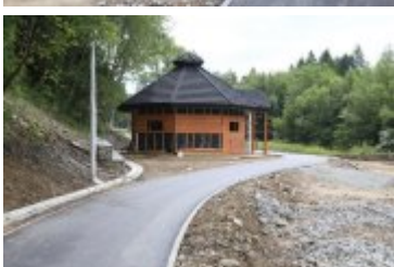
• 2019-06-24-Postępy prac na budowie bulwarów nad Poniczanką
