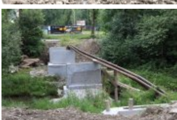
• 2019-06-24-Postępy prac na budowie bulwarów nad Poniczanką
