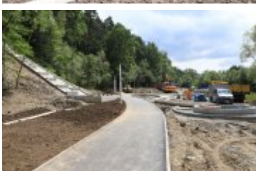
• 2019-06-24-Postępy prac na budowie bulwarów nad Poniczanką
