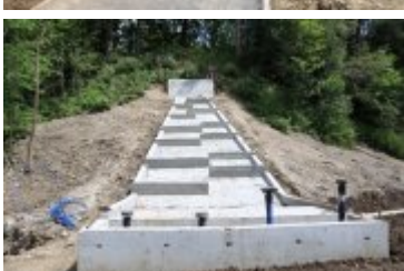
• 2019-06-24-Postępy prac na budowie bulwarów nad Poniczanką
