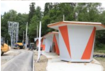
• 2019-06-24-Postępy prac na budowie bulwarów nad Poniczanką
