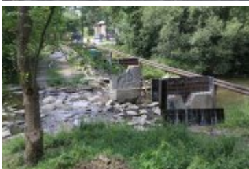
• 2019-06-24-Postępy prac na budowie bulwarów nad Poniczanką
