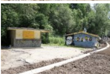
• 2019-06-24-Postępy prac na budowie bulwarów nad Poniczanką
