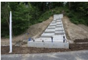
• 2019-06-24-Postępy prac na budowie bulwarów nad Poniczanką
