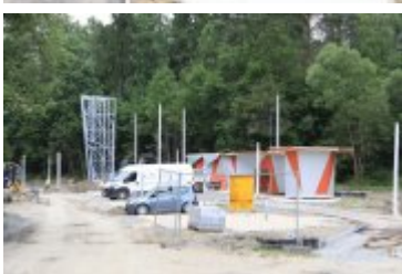
• 2019-06-24-Postępy prac na budowie bulwarów nad Poniczanką
