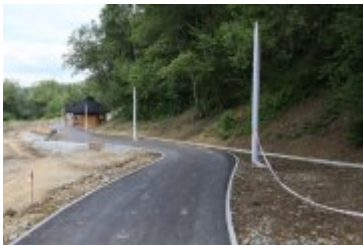
• 2019-06-24-Postępy prac na budowie bulwarów nad Poniczanką
