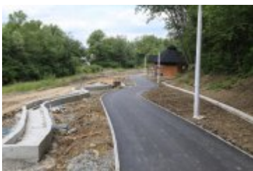
• 2019-06-24-Postępy prac na budowie bulwarów nad Poniczanką
