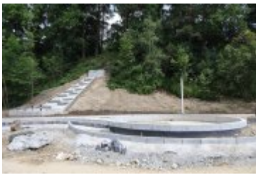
• 2019-06-24-Postępy prac na budowie bulwarów nad Poniczanką
