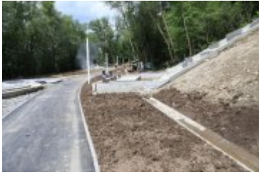
• 2019-06-24-Postępy prac na budowie bulwarów nad Poniczanką
