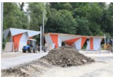
• 2019-06-24-Postępy prac na budowie bulwarów nad Poniczanką
