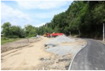
• 2019-06-24-Postępy prac na budowie bulwarów nad Poniczanką
