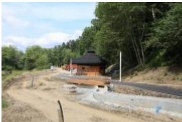
• 2019-06-24-Postępy prac na budowie bulwarów nad Poniczanką
