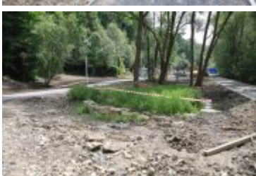
• 2019-06-24-Postępy prac na budowie bulwarów nad Poniczanką
