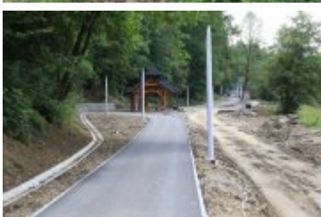
• 2019-06-24-Postępy prac na budowie bulwarów nad Poniczanką
