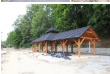
• 2019-06-24-Postępy prac na budowie bulwarów nad Poniczanką
