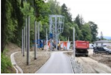
• 2019-06-24-Postępy prac na budowie bulwarów nad Poniczanką
