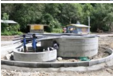
• 2019-06-24-Postępy prac na budowie bulwarów nad Poniczanką
