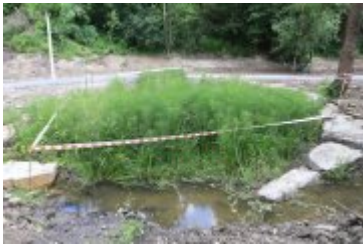
• 2019-06-24-Postępy prac na budowie bulwarów nad Poniczanką
