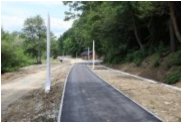
• 2019-06-24-Postępy prac na budowie bulwarów nad Poniczanką
