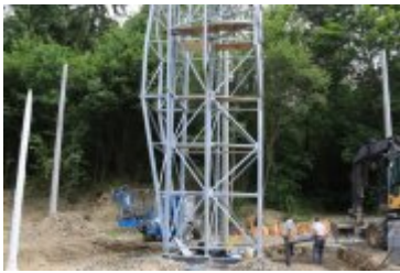
• 2019-06-24-Postępy prac na budowie bulwarów nad Poniczanką
