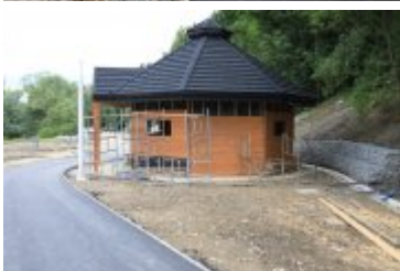
• 2019-06-24-Postępy prac na budowie bulwarów nad Poniczanką
