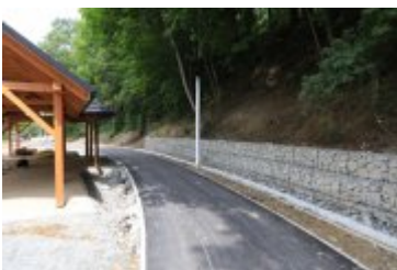
• 2019-06-24-Postępy prac na budowie bulwarów nad Poniczanką
