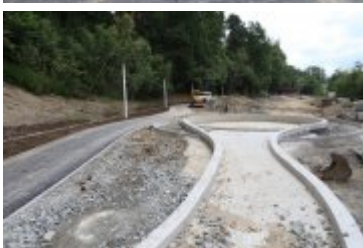
• 2019-06-24-Postępy prac na budowie bulwarów nad Poniczanką
