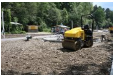
• 2019-06-24-Postępy prac na budowie bulwarów nad Poniczanką
