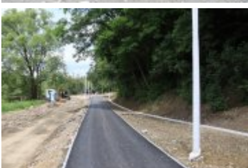
• 2019-06-24-Postępy prac na budowie bulwarów nad Poniczanką
