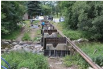
• 2019-06-24-Postępy prac na budowie bulwarów nad Poniczanką
