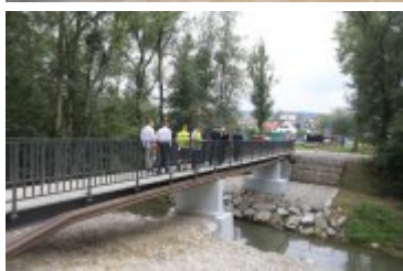
2019-09-02-Odbiory techniczne bulwarów nad Poniczanką
