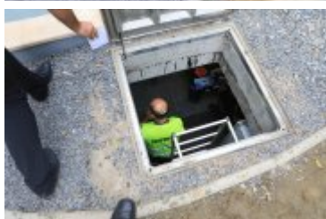
2019-09-02-Odbiory techniczne bulwarów nad Poniczanką
