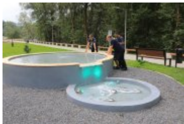
• 2019-09-02-Odbiory techniczne bulwarów nad Poniczanką
