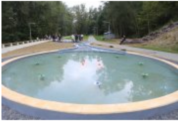
• 2019-09-02-Odbiory techniczne bulwarów nad Poniczanką
