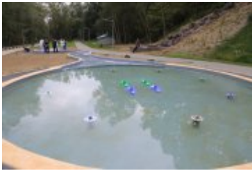
• 2019-09-02-Odbiory techniczne bulwarów nad Poniczanką
