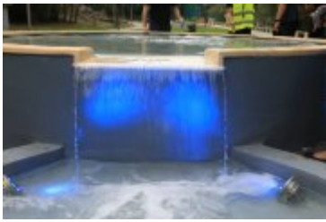
• 2019-09-02-Odbiory techniczne bulwarów nad Poniczanką
