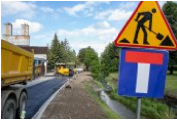
• 2020-08-25-Układanie dywanika asfaltowego na Alei Tysiąclecia
