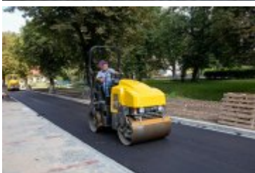
• 2020-08-25-Układanie dywanika asfaltowego na Alei Tysiąclecia
