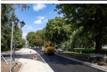
• 2020-08-25-Układanie dywanika asfaltowego na Alei Tysiąclecia
