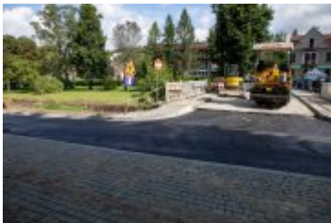
• 2020-08-25-Układanie dywanika asfaltowego na Alei Tysiąclecia
