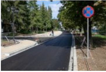
• 2020-08-25-Układanie dywanika asfaltowego na Alei Tysiąclecia
