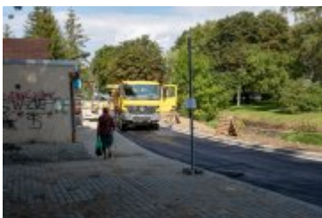
• 2020-08-25-Układanie dywanika asfaltowego na Alei Tysiąclecia
