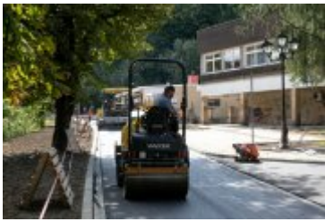
• 2020-08-25-Układanie dywanika asfaltowego na Alei Tysiąclecia
