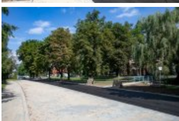
• 2020-08-25-Układanie dywanika asfaltowego na Alei Tysiąclecia
