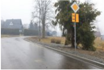
• 2020-12-23-Remont drogi na osiedlu Traczykówka
