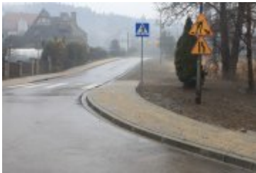
• 2020-12-23-Remont drogi na osiedlu Traczykówka
