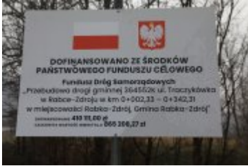
• 2020-12-23-Remont drogi na osiedlu Traczykówka
