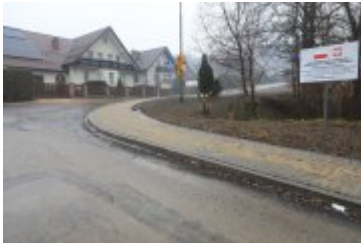
• 2020-12-23-Remont drogi na osiedlu Traczykówka
