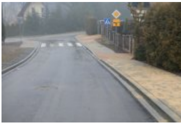
• 2020-12-23-Remont drogi na osiedlu Traczykówka
