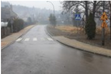
• 2020-12-23-Remont drogi na osiedlu Traczykówka
