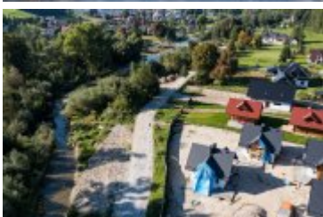
2021-09-09-Budowa nowego mostu na Poniczance
