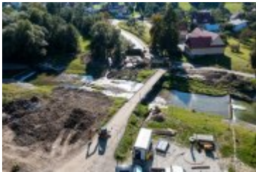
2021-09-09-Budowa nowego mostu na Poniczance
