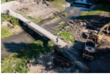
2021-09-09-Budowa nowego mostu na Poniczance
