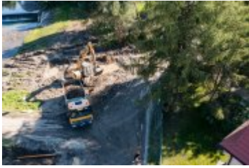
2021-09-09-Budowa nowego mostu na Poniczance
