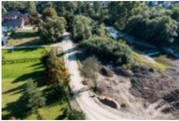
2021-09-09-Budowa nowego mostu na Poniczance
