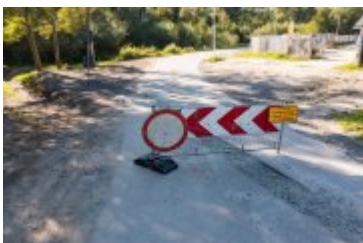
2021-09-09-Budowa nowego mostu na Poniczance
