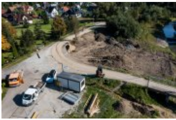
2021-09-09-Budowa nowego mostu na Poniczance
