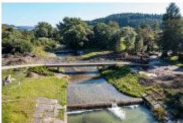
2021-09-09-Budowa nowego mostu na Poniczance
