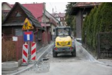
2021-11-08-Remont ulicy Zgody
