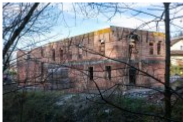
2021-11-13- Budowa remizy OSP w Ponicach
