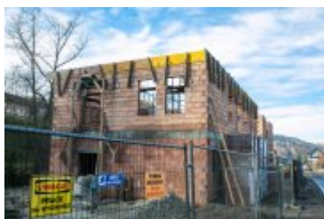
2021-11-13- Budowa remizy OSP w Ponicach
