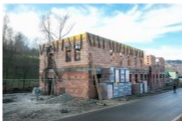
2021-11-13- Budowa remizy OSP w Ponicach
