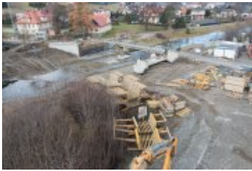
• 2021-11-22-Postępy prac na budowie mostu na Poniczance
