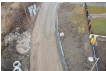
• 2021-11-22-Postępy prac na budowie mostu na Poniczance
