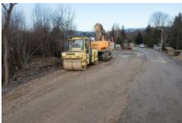
• 2021-11-22-Postępy prac na budowie mostu na Poniczance
