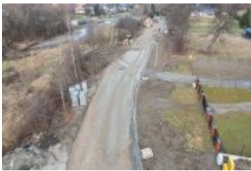
• 2021-11-22-Postępy prac na budowie mostu na Poniczance
