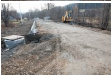
• 2021-11-22-Postępy prac na budowie mostu na Poniczance
