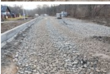
• 2021-11-22-Postępy prac na budowie mostu na Poniczance
