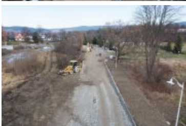
• 2021-11-22-Postępy prac na budowie mostu na Poniczance
