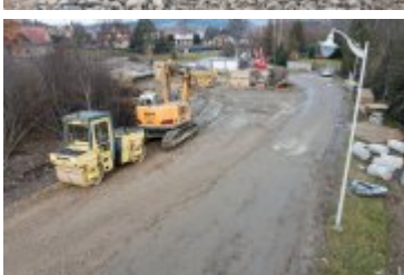
• 2021-11-22-Postępy prac na budowie mostu na Poniczance
