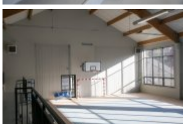
• 2021-11-25-Budowa sali gimnastycznej w Chabówce
