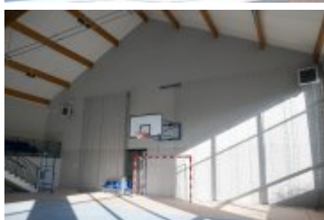
• 2021-11-25-Budowa sali gimnastycznej w Chabówce
