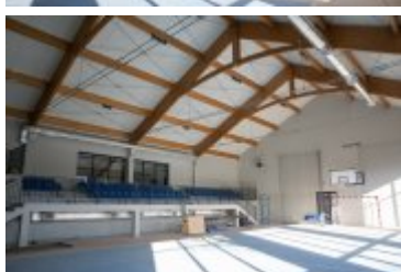
• 2021-11-25-Budowa sali gimnastycznej w Chabówce
