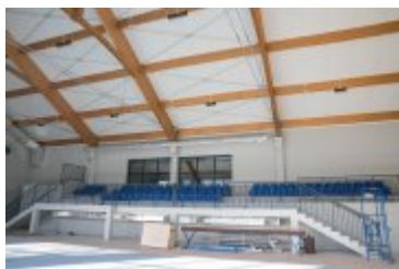
• 2021-11-25-Budowa sali gimnastycznej w Chabówce
