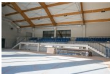
• 2021-11-25-Budowa sali gimnastycznej w Chabówce
