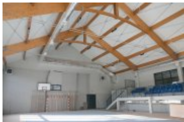
• 2021-11-25-Budowa sali gimnastycznej w Chabówce
