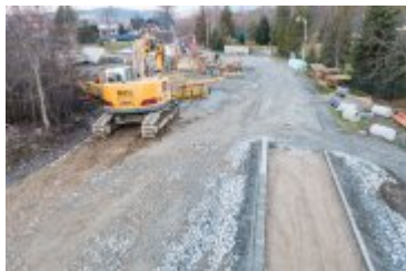
• 2021-12-01-Postępy prac na budowie mostu na Poniczance
