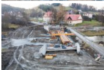
• 2021-12-01-Postępy prac na budowie mostu na Poniczance
