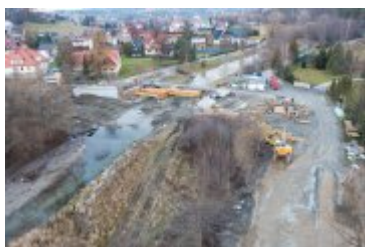
• 2021-12-01-Postępy prac na budowie mostu na Poniczance
