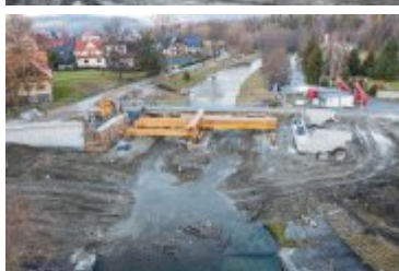
• 2021-12-01-Postępy prac na budowie mostu na Poniczance
