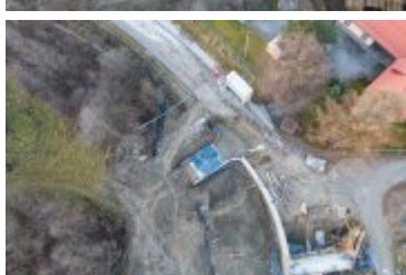
• 2021-12-01-Postępy prac na budowie mostu na Poniczance
