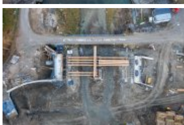
• 2021-12-01-Postępy prac na budowie mostu na Poniczance
