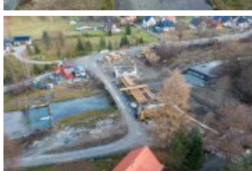
• 2021-12-01-Postępy prac na budowie mostu na Poniczance
