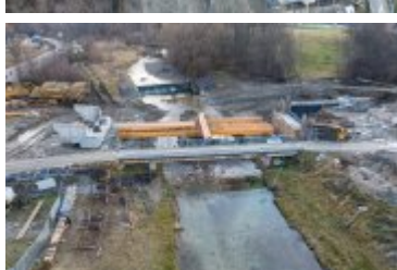
• 2021-12-01-Postępy prac na budowie mostu na Poniczance
