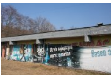
• 2022-03-18-Adaptacja pomieszczeń na magazyn dla uchodźców
