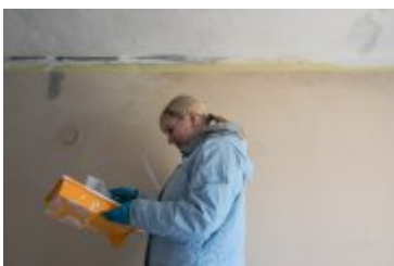
• 2022-03-18-Adaptacja pomieszczeń na magazyn dla uchodźców
