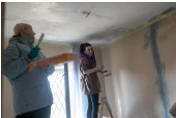
• 2022-03-18-Adaptacja pomieszczeń na magazyn dla uchodźców
