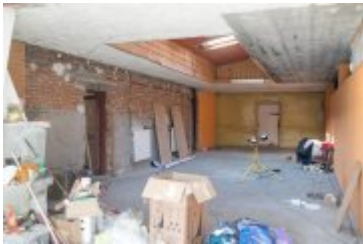
• 2022-03-18-Adaptacja pomieszczeń na magazyn dla uchodźców
