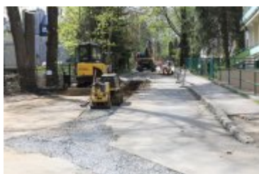
• 2022-05-11-Remont ulicy Brzozowej
