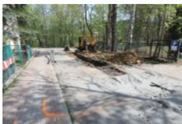
2022-05-11-Remont ulicy Brzozowej
