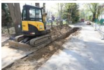
• 2022-05-11-Remont ulicy Brzozowej
