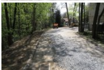
• 2022-05-11-Remont ulicy Brzozowej
