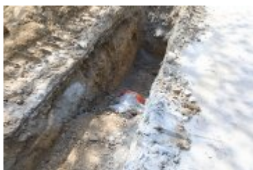
2022-05-11-Remont ulicy Brzozowej
