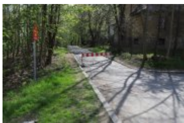
• 2022-05-11-Remont ulicy Brzozowej
