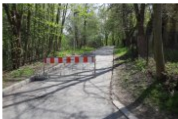
• 2022-05-11-Remont ulicy Brzozowej
