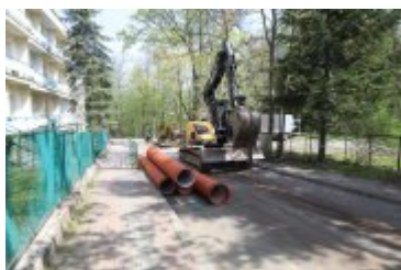
2022-05-11-Remont ulicy Brzozowej
