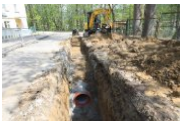
2022-05-11-Remont ulicy Brzozowej
