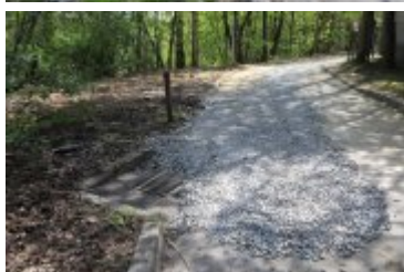
• 2022-05-11-Remont ulicy Brzozowej
