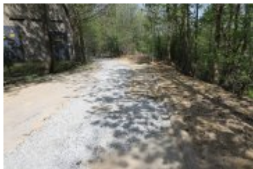
• 2022-05-11-Remont ulicy Brzozowej
