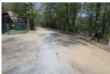
• 2022-05-11-Remont ulicy Brzozowej
