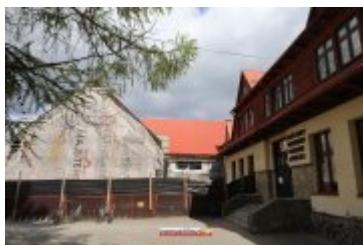
• 2017-05-09-Budowa sali gimnastycznej w Ponicach
