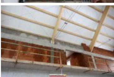
• 2017-05-09-Budowa sali gimnastycznej w Ponicach
