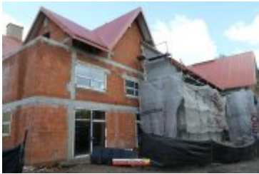
• 2017-05-09-Budowa sali gimnastycznej w Ponicach
