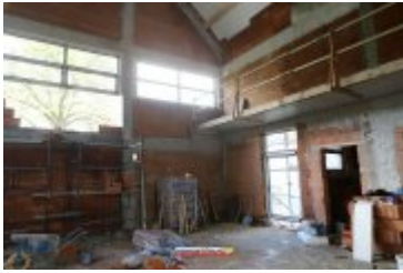
• 2017-05-09-Budowa sali gimnastycznej w Ponicach
