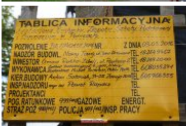
• 2017-05-09-Budowa sali gimnastycznej w Ponicach
