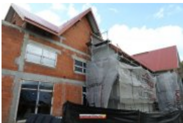
• 2017-05-09-Budowa sali gimnastycznej w Ponicach
