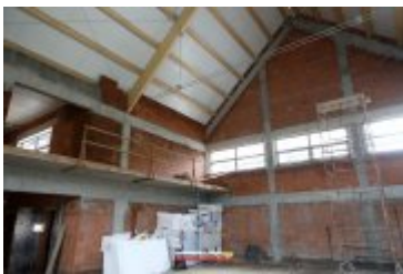
• 2017-05-09-Budowa sali gimnastycznej w Ponicach
