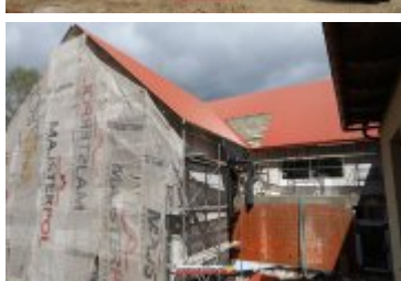
• 2017-05-09-Budowa sali gimnastycznej w Ponicach
