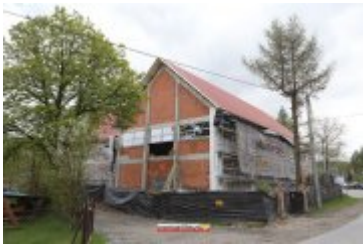
• 2017-05-09-Budowa sali gimnastycznej w Ponicach
