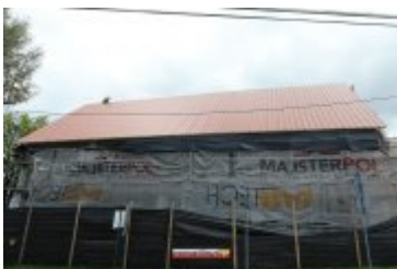
• 2017-05-09-Budowa sali gimnastycznej w Ponicach
