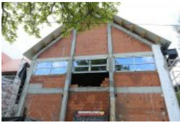
• 2017-05-09-Budowa sali gimnastycznej w Ponicach
