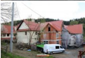
• 2017-05-09-Budowa sali gimnastycznej w Ponicach
