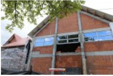
• 2017-05-09-Budowa sali gimnastycznej w Ponicach
