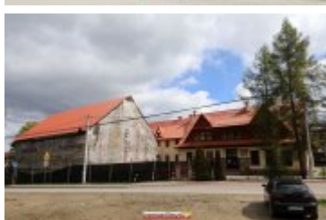
• 2017-05-09-Budowa sali gimnastycznej w Ponicach
