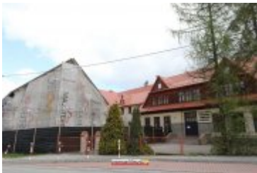
• 2017-05-09-Budowa sali gimnastycznej w Ponicach
