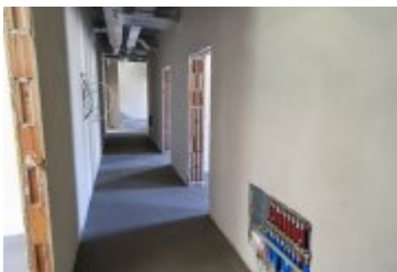
2022-08-30-Budowa remizy OSP w Ponicach
