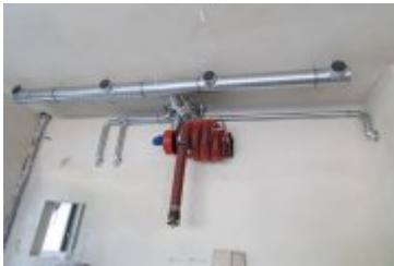
2022-08-30-Budowa remizy OSP w Ponicach
