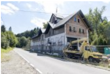
2022-08-30-Budowa remizy OSP w Ponicach
