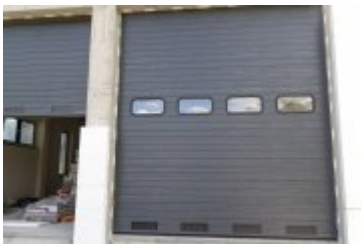
2022-08-30-Budowa remizy OSP w Ponicach
