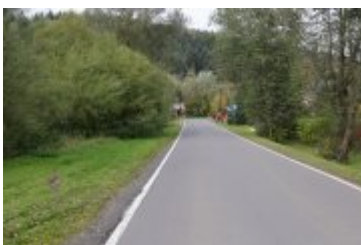
• 2022-10-06-Remont drogi w Ponicach
