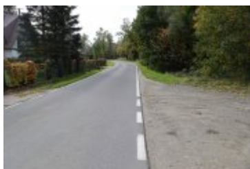
2022-10-06-Remont drogi w Ponicach
