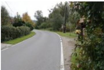
• 2022-10-06-Remont drogi w Ponicach
