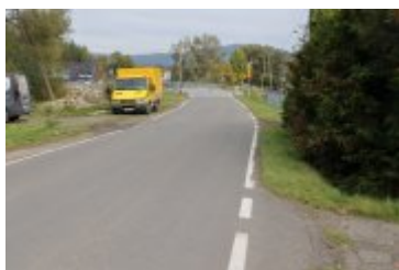
2022-10-06-Remont drogi w Ponicach
