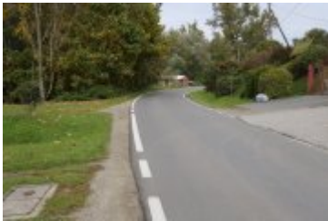
• 2022-10-06-Remont drogi w Ponicach
