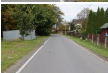
• 2022-10-06-Remont drogi w Ponicach
