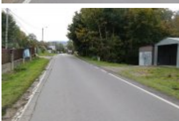
• 2022-10-06-Remont drogi w Ponicach
