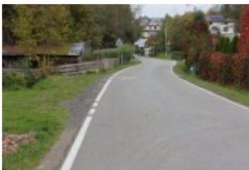
2022-10-06-Remont drogi w Ponicach
