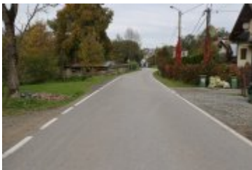
2022-10-06-Remont drogi w Ponicach
