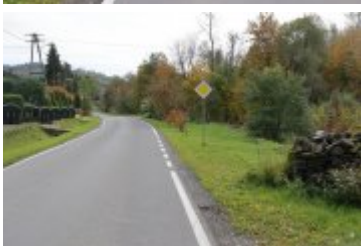
• 2022-10-06-Remont drogi w Ponicach
