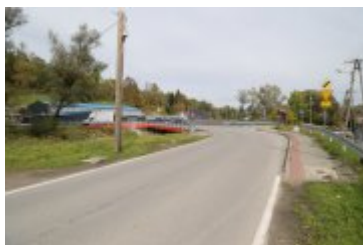
2022-10-06-Remont drogi w Ponicach
