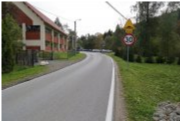
2022-10-06-Remont drogi w Ponicach
