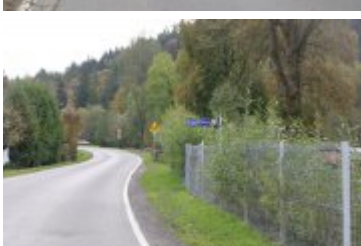
• 2022-10-06-Remont drogi w Ponicach
