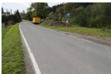
2022-10-06-Remont drogi w Ponicach
