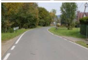
2022-10-06-Remont drogi w Ponicach
