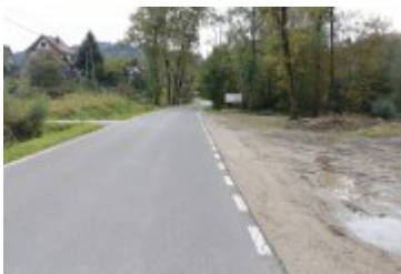
• 2022-10-06-Remont drogi w Ponicach
