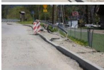
• 2023-05-10-Remont drogi powiatowej w Ponicach
