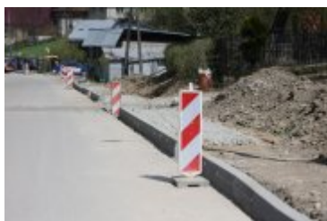
• 2023-05-10-Remont drogi powiatowej w Ponicach
