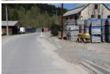
• 2023-05-10-Remont drogi powiatowej w Ponicach
