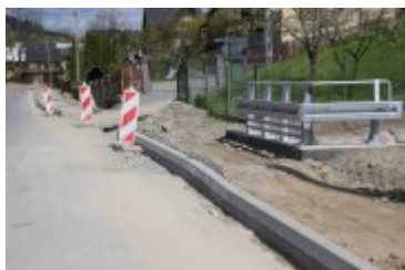
• 2023-05-10-Remont drogi powiatowej w Ponicach
