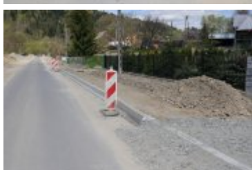
• 2023-05-10-Remont drogi powiatowej w Ponicach
