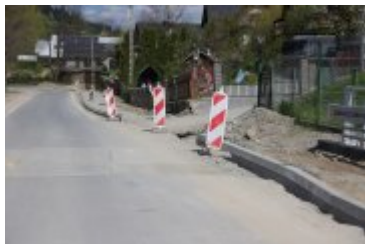
• 2023-05-10-Remont drogi powiatowej w Ponicach
