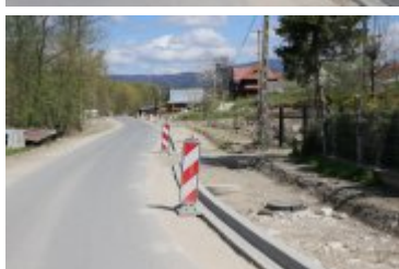
• 2023-05-10-Remont drogi powiatowej w Ponicach
