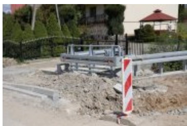
• 2023-05-10-Remont drogi powiatowej w Ponicach
