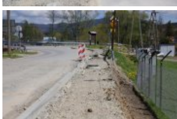
• 2023-05-10-Remont drogi powiatowej w Ponicach
