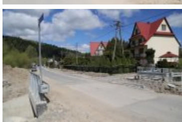
• 2023-05-10-Remont drogi powiatowej w Ponicach
