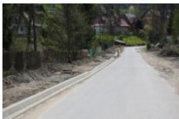
• 2023-05-10-Remont drogi powiatowej w Ponicach
