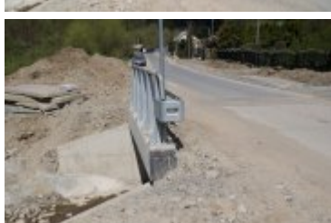
• 2023-05-10-Remont drogi powiatowej w Ponicach
