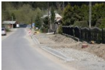
• 2023-05-10-Remont drogi powiatowej w Ponicach
