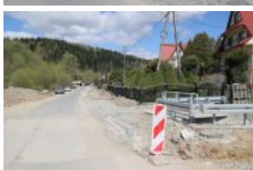
• 2023-05-10-Remont drogi powiatowej w Ponicach
