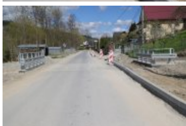
• 2023-05-10-Remont drogi powiatowej w Ponicach
