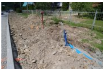
2023-06-29-Remont ulicy Poniatowskiego
