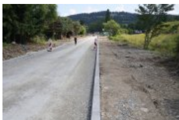
2023-06-29-Remont ulicy Poniatowskiego
