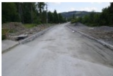
2023-06-29-Remont ulicy Poniatowskiego
