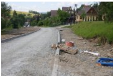
• 2023-06-29-Remont ulicy Poniatowskiego
