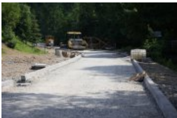
• 2023-06-29-Remont ulicy Poniatowskiego
