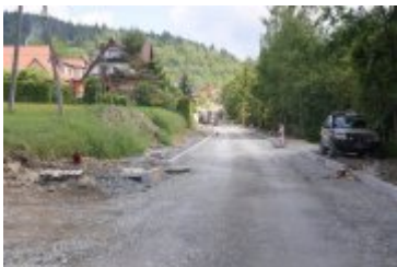
• 2023-06-29-Remont ulicy Poniatowskiego
