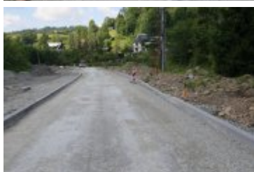
2023-06-29-Remont ulicy Poniatowskiego
