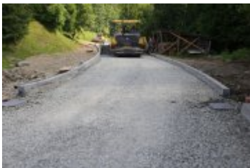
• 2023-06-29-Remont ulicy Poniatowskiego
