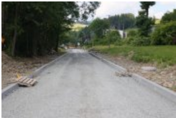
• 2023-06-29-Remont ulicy Poniatowskiego
