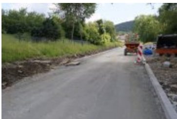
• 2023-06-29-Remont ulicy Poniatowskiego
