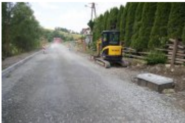
• 2023-06-29-Remont ulicy Poniatowskiego
