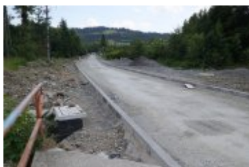
2023-06-29-Remont ulicy Poniatowskiego
