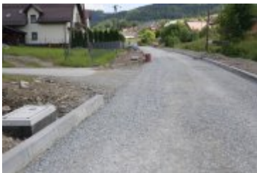
• 2023-06-29-Remont ulicy Poniatowskiego
