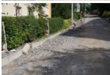
2023-08-09-Remont ulicy Słowackiego
