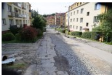
• 2023-08-09-Remont ulicy Słowackiego
