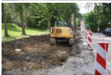
• 2023-08-09-Remont ulicy Słowackiego
