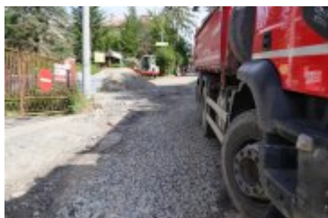
• 2023-08-09-Remont ulicy Słowackiego
