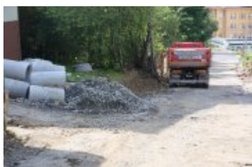
• 2023-08-09-Remont ulicy Słowackiego
