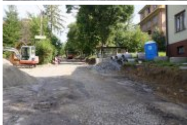
• 2023-08-09-Remont ulicy Słowackiego
