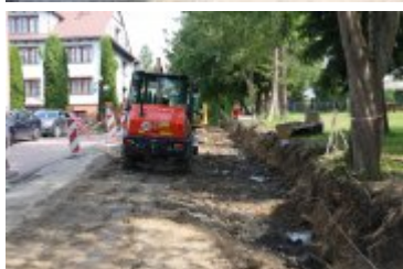
• 2023-08-09-Remont ulicy Słowackiego
