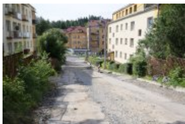
• 2023-08-09-Remont ulicy Słowackiego
