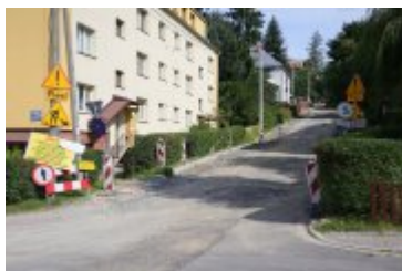
2023-08-09-Remont ulicy Słowackiego
