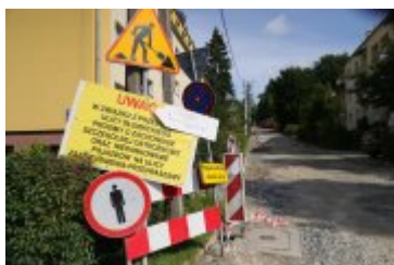
2023-08-09-Remont ulicy Słowackiego
