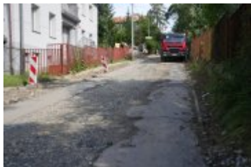
• 2023-08-09-Remont ulicy Słowackiego
