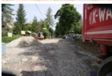
• 2023-08-09-Remont ulicy Słowackiego
