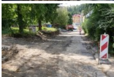
• 2023-08-09-Remont ulicy Słowackiego
