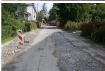
2023-08-09-Remont ulicy Słowackiego
