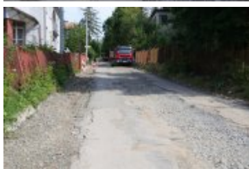
2023-08-09-Remont ulicy Słowackiego
