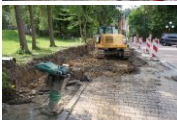
• 2023-08-09-Remont ulicy Słowackiego
