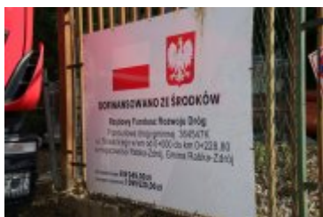
• 2023-08-09-Remont ulicy Słowackiego
