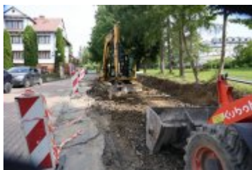
• 2023-08-09-Remont ulicy Słowackiego
