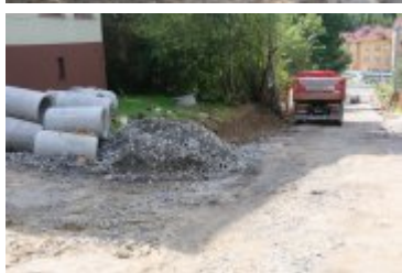
• 2023-08-09-Remont ulicy Słowackiego
