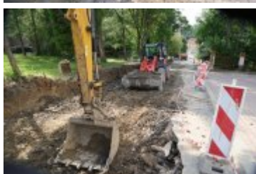
• 2023-08-09-Remont ulicy Słowackiego
