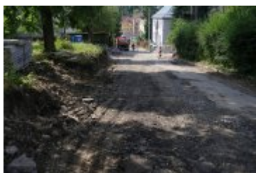
• 2023-08-09-Remont ulicy Słowackiego
