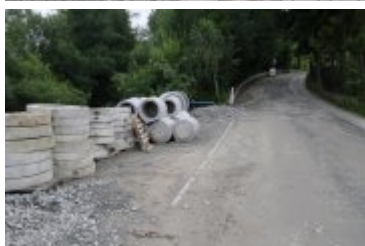
2023-08-10-Remont ulicy Bystrej
