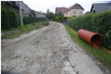
• 2023-08-10-Remont ulicy Bystrej
