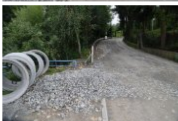
2023-08-10-Remont ulicy Bystrej
