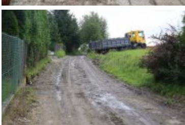
• 2023-08-10-Remont ulicy Bystrej
