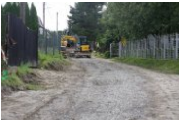
• 2023-08-10-Remont ulicy Bystrej
