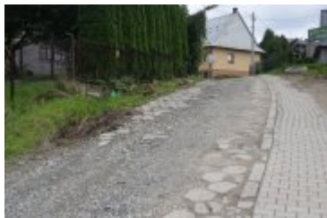
2023-08-10-Remont ulicy Bystrej
