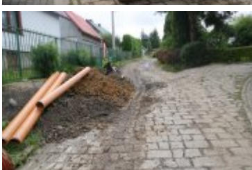
• 2023-08-10-Remont ulicy Bystrej
