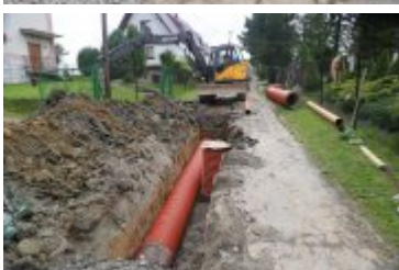
• 2023-08-10-Remont ulicy Bystrej
