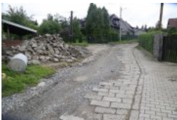
• 2023-08-10-Remont ulicy Bystrej
