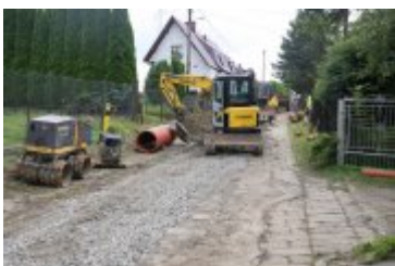
• 2023-08-10-Remont ulicy Bystrej
