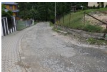
2023-08-10-Remont ulicy Bystrej
