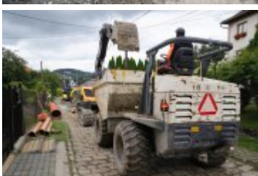
• 2023-08-10-Remont ulicy Bystrej
