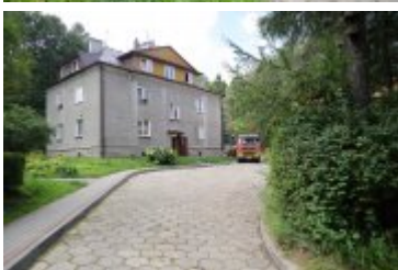
• 2023-08-22-Przebudowa drogi osiedlowej przy ul. Chopina
