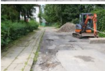
• 2023-08-22-Przebudowa drogi osiedlowej przy ul. Chopina
