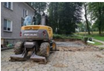
• 2023-08-22-Przebudowa drogi osiedlowej przy ul. Chopina
