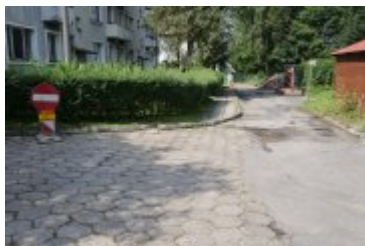
2023-08-22-Przebudowa drogi osiedlowej przy ul. Chopina
