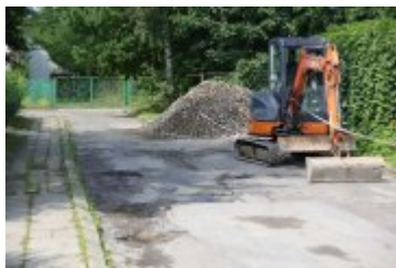
2023-08-22-Przebudowa drogi osiedlowej przy ul. Chopina
