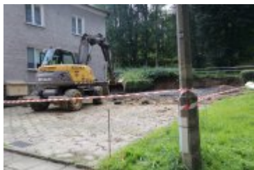
2023-08-22-Przebudowa drogi osiedlowej przy ul. Chopina
