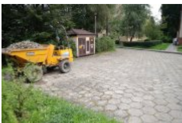
• 2023-08-22-Przebudowa drogi osiedlowej przy ul. Chopina
