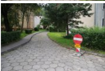
• 2023-08-22-Przebudowa drogi osiedlowej przy ul. Chopina
