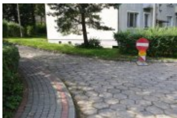
2023-08-22-Przebudowa drogi osiedlowej przy ul. Chopina
