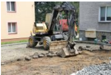
• 2023-08-22-Przebudowa drogi osiedlowej przy ul. Chopina
