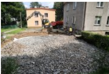
• 2023-08-22-Przebudowa drogi osiedlowej przy ul. Chopina
