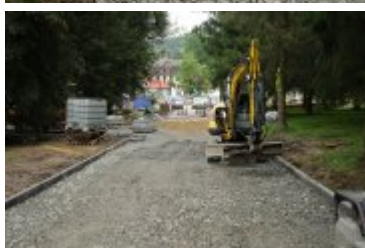
• 2023-08-29-Remont rabczańskiego deptaka
