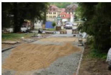
• 2023-08-29-Remont rabczańskiego deptaka
