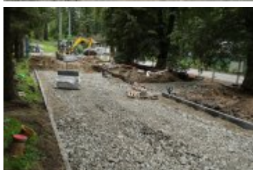
• 2023-08-29-Remont rabczańskiego deptaka
