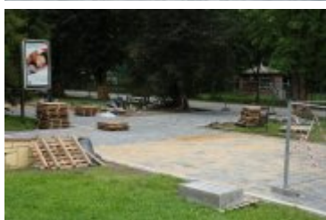
2023-08-29-Remont rabczańskiego deptaka
