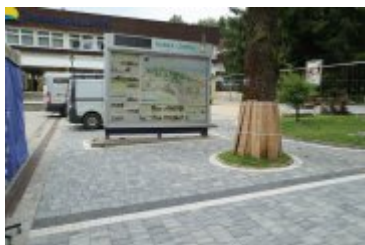
2023-08-29-Remont rabczańskiego deptaka
