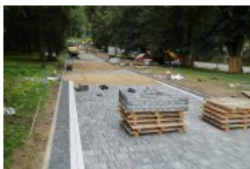
• 2023-08-29-Remont rabczańskiego deptaka
