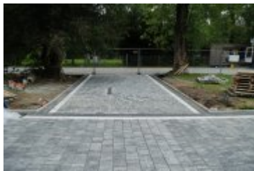
• 2023-08-29-Remont rabczańskiego deptaka
