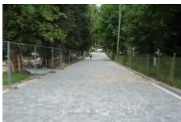
2023-08-29-Remont rabczańskiego deptaka
