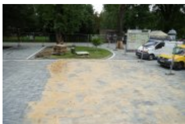
2023-08-29-Remont rabczańskiego deptaka
