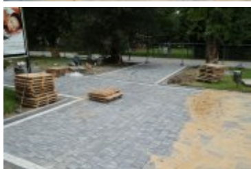
2023-08-29-Remont rabczańskiego deptaka
