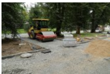
• 2023-08-29-Remont rabczańskiego deptaka
