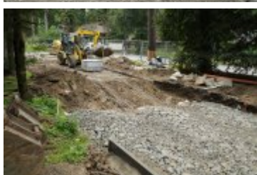
• 2023-08-29-Remont rabczańskiego deptaka
