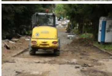
• 2023-08-29-Remont rabczańskiego deptaka
