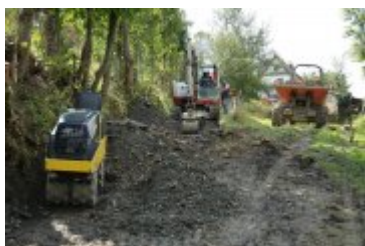
2023-09-04-Przebudowa ulicy Gorczańskiej
