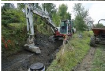
2023-09-04-Przebudowa ulicy Gorczańskiej
