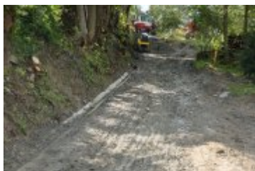
2023-09-04-Przebudowa ulicy Gorczańskiej
