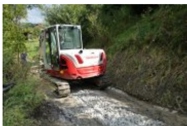
2023-09-04-Przebudowa ulicy Gorczańskiej
