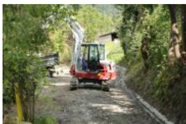
2023-09-04-Przebudowa ulicy Gorczańskiej
