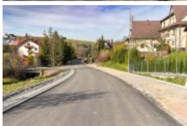
2023-11-10-Remont ulicy Poniatowskiego
