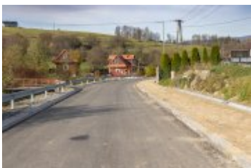
• 2023-11-10-Remont ulicy Poniatowskiego
