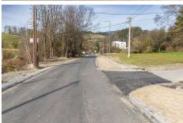
• 2023-11-10-Remont ulicy Poniatowskiego
