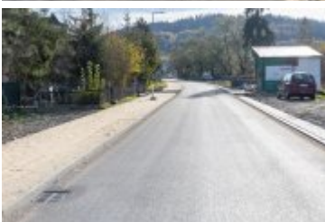
• 2023-11-10-Remont ulicy Poniatowskiego
