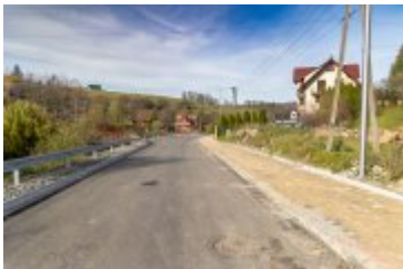
• 2023-11-10-Remont ulicy Poniatowskiego
