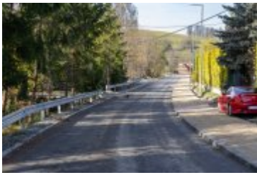
• 2023-11-10-Remont ulicy Poniatowskiego
