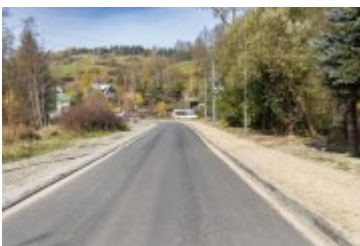
• 2023-11-10-Remont ulicy Poniatowskiego
