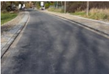
• 2023-11-10-Remont ulicy Poniatowskiego
