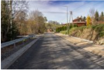
• 2023-11-10-Remont ulicy Poniatowskiego
