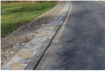
• 2023-11-10-Remont ulicy Poniatowskiego
