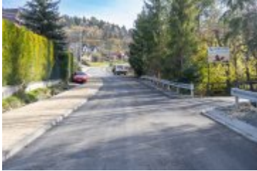
• 2023-11-10-Remont ulicy Poniatowskiego
