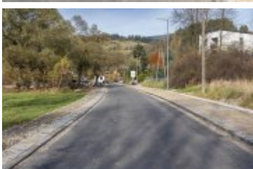
• 2023-11-10-Remont ulicy Poniatowskiego
