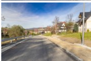
2023-11-10-Remont ulicy Poniatowskiego
