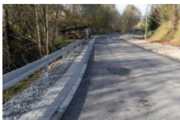
2023-11-10-Remont ulicy Poniatowskiego
