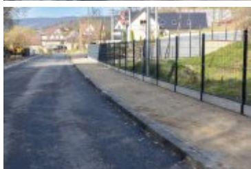
2023-11-10-Remont ulicy Poniatowskiego
