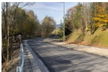
2023-11-10-Remont ulicy Poniatowskiego
