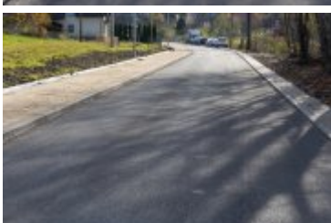
• 2023-11-10-Remont ulicy Poniatowskiego
