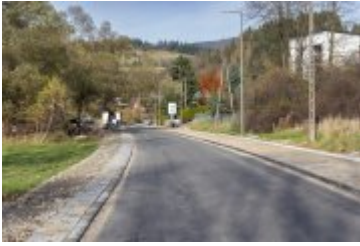
• 2023-11-10-Remont ulicy Poniatowskiego
