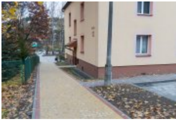
• 2023-11-16-Zakończenie remontu na os. Chopina
