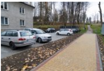
• 2023-11-16-Zakończenie remontu na os. Chopina
