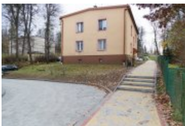
• 2023-11-16-Zakończenie remontu na os. Chopina
