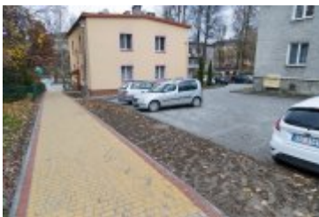
• 2023-11-16-Zakończenie remontu na os. Chopina
