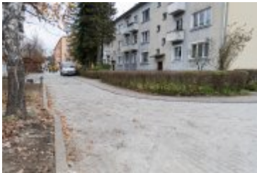
• 2023-11-16-Zakończenie remontu na os. Chopina
