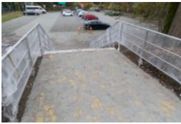
• 2023-11-16-Zakończenie remontu na os. Chopina
