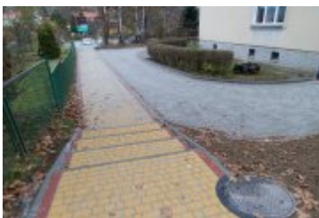
• 2023-11-16-Zakończenie remontu na os. Chopina
