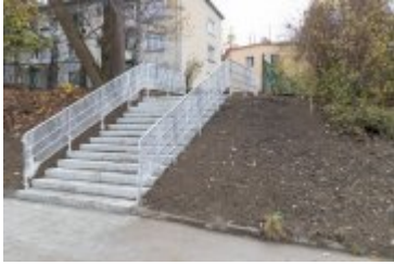
• 2023-11-16-Zakończenie remontu na os. Chopina
