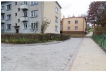
• 2023-11-16-Zakończenie remontu na os. Chopina
