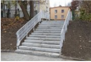
• 2023-11-16-Zakończenie remontu na os. Chopina
