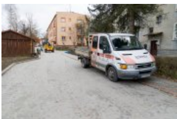
• 2023-11-16-Zakończenie remontu na os. Chopina
