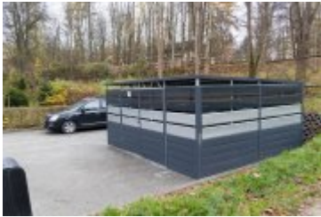
• 2023-11-16-Zakończenie remontu na os. Chopina
