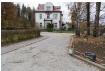
• 2023-11-16-Zakończenie remontu na os. Chopina
