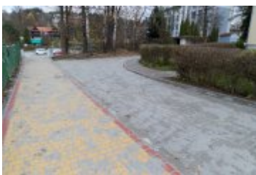
• 2023-11-16-Zakończenie remontu na os. Chopina
