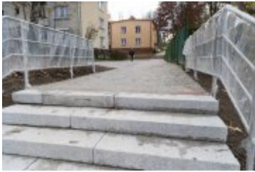
• 2023-11-16-Zakończenie remontu na os. Chopina
