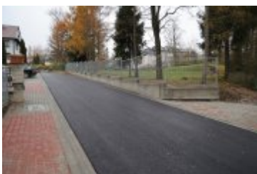
• 2023-11-22-Ulica Słowackiego po remoncie
