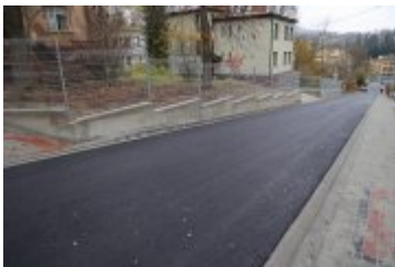
• 2023-11-22-Ulica Słowackiego po remoncie
