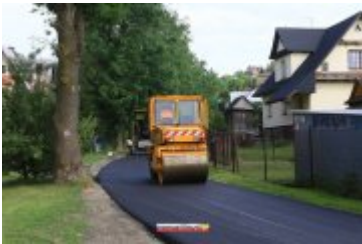
• 2017-06-30-Nowa nawierzchnia na Alei Tysiąclecia
