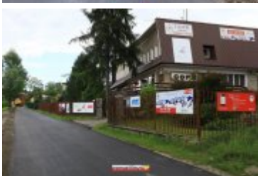
• 2017-06-30-Nowa nawierzchnia na Alei Tysiąclecia
