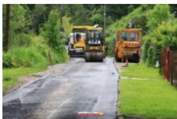
2017-06-30-Nowa nawierzchnia na Alei Tysiąclecia
