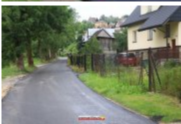
• 2017-06-30-Nowa nawierzchnia na Alei Tysiąclecia
