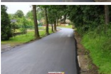
• 2017-06-30-Nowa nawierzchnia na Alei Tysiąclecia
