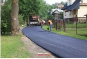
• 2017-06-30-Nowa nawierzchnia na Alei Tysiąclecia
