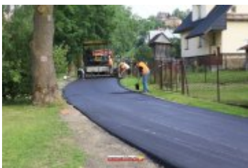
• 2017-06-30-Nowa nawierzchnia na Alei Tysiąclecia
