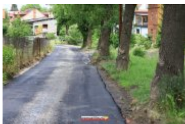
2017-06-30-Nowa nawierzchnia na Alei Tysiąclecia
