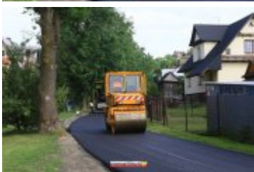
• 2017-06-30-Nowa nawierzchnia na Alei Tysiąclecia
