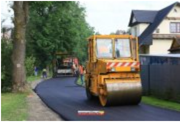
• 2017-06-30-Nowa nawierzchnia na Alei Tysiąclecia
