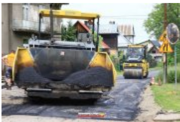
• 2017-06-30-Nowa nawierzchnia na Alei Tysiąclecia
