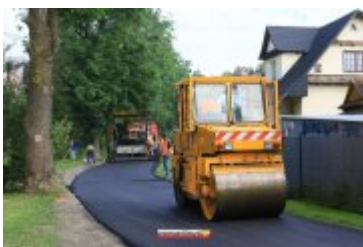
• 2017-06-30-Nowa nawierzchnia na Alei Tysiąclecia
