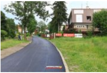
• 2017-06-30-Nowa nawierzchnia na Alei Tysiąclecia
