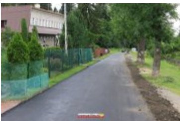
• 2017-06-30-Nowa nawierzchnia na Alei Tysiąclecia
