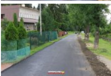
• 2017-06-30-Nowa nawierzchnia na Alei Tysiąclecia
