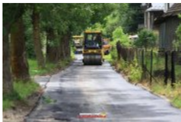
2017-06-30-Nowa nawierzchnia na Alei Tysiąclecia
