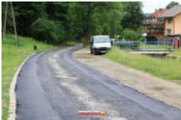
• 2017-06-30-Nowa nawierzchnia na Alei Tysiąclecia
