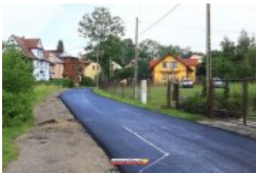
• 2017-06-30-Nowa nawierzchnia na Alei Tysiąclecia
