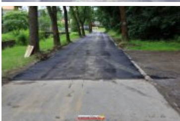
• 2017-06-30-Nowa nawierzchnia na Alei Tysiąclecia
