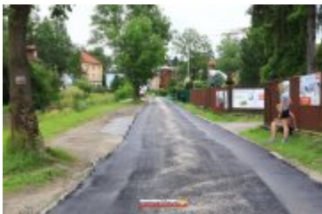
• 2017-06-30-Nowa nawierzchnia na Alei Tysiąclecia
