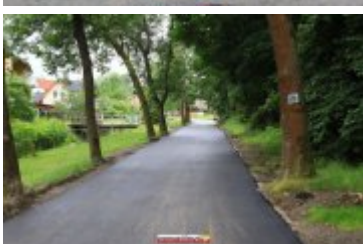
• 2017-06-30-Nowa nawierzchnia na Alei Tysiąclecia
