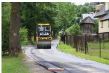
2017-06-30-Nowa nawierzchnia na Alei Tysiąclecia
