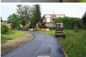
• 2017-06-30-Nowa nawierzchnia na Alei Tysiąclecia
