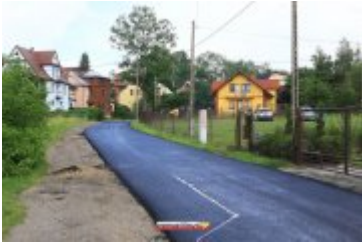
• 2017-06-30-Nowa nawierzchnia na Alei Tysiąclecia
