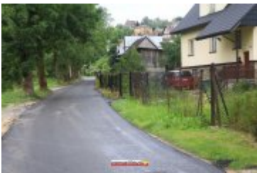
• 2017-06-30-Nowa nawierzchnia na Alei Tysiąclecia
