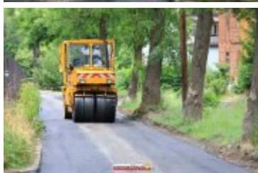
2017-06-30-Nowa nawierzchnia na Alei Tysiąclecia
