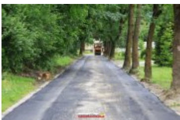
• 2017-06-30-Nowa nawierzchnia na Alei Tysiąclecia
