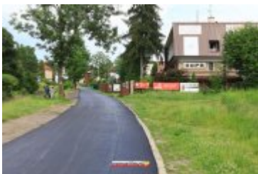
• 2017-06-30-Nowa nawierzchnia na Alei Tysiąclecia
