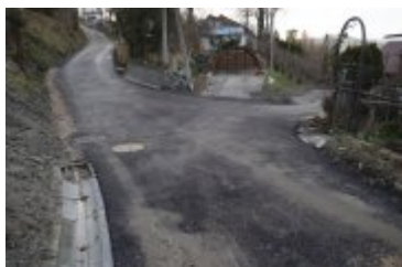
2023-12-28-Remont ulicy Wójtowiczowa
