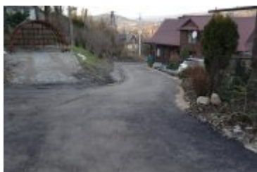
2023-12-28-Remont ulicy Wójtowiczowa
