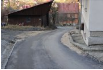
• 2023-12-28-Remont ulicy Wójtowiczowa
