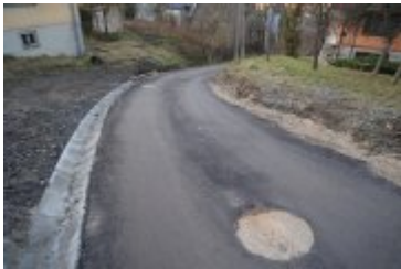
• 2023-12-28-Remont ulicy Wójtowiczowa
