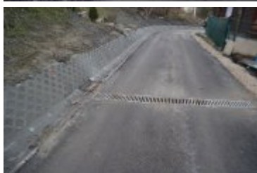
2023-12-28-Remont ulicy Wójtowiczowa
