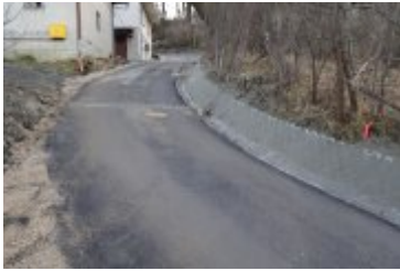
• 2023-12-28-Remont ulicy Wójtowiczowa
