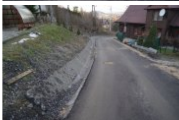
2023-12-28-Remont ulicy Wójtowiczowa
