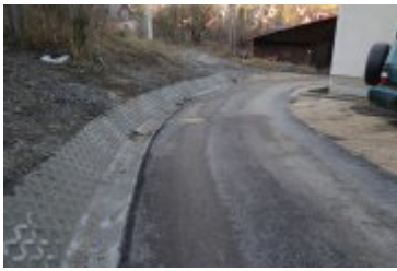
• 2023-12-28-Remont ulicy Wójtowiczowa
