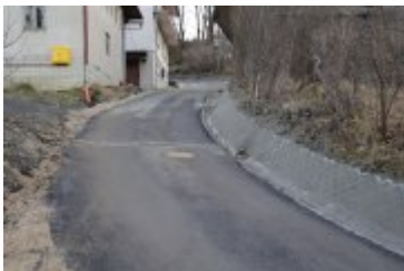
• 2023-12-28-Remont ulicy Wójtowiczowa
