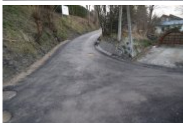
2023-12-28-Remont ulicy Wójtowiczowa
