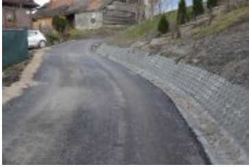
• 2023-12-28-Remont ulicy Wójtowiczowa
